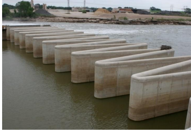
Figura 2.3. Ápices circulares del vertedor tipo laberinto de la presa Brazos, Texas, USA.
