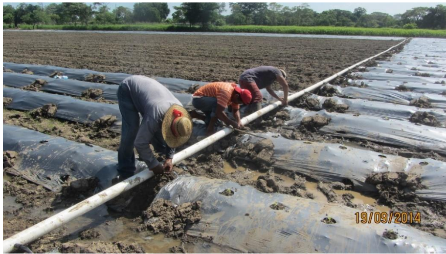
Figura 9.7 Instalación de sistema de riego por goteo con cintas y cubierta plástica
