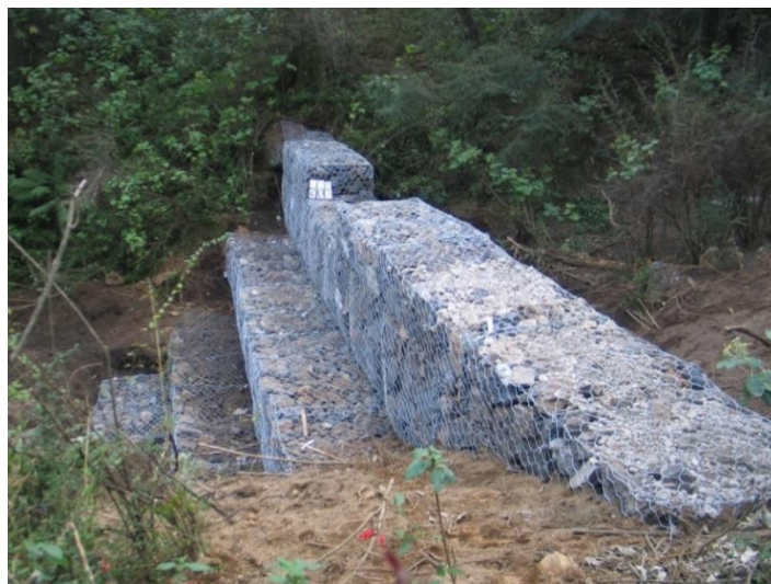
Figura 2.63 Presa de gaviones rellenos de piedra
