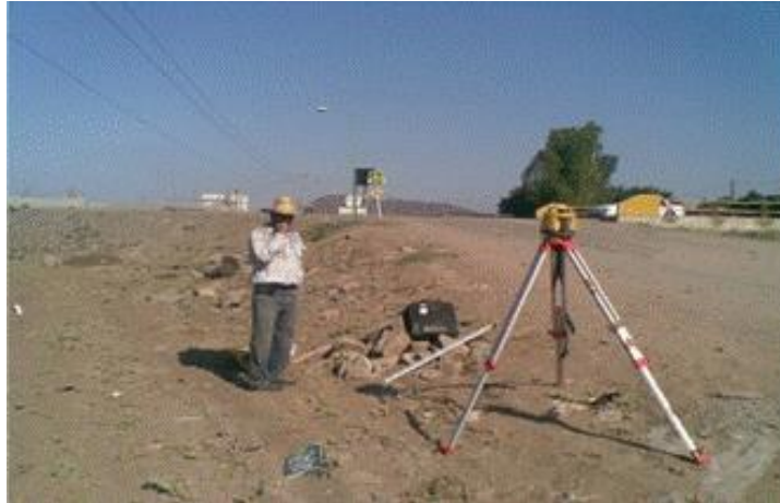
Figura 3.28 Posicionamiento del equipo para el levantamiento topográfico
