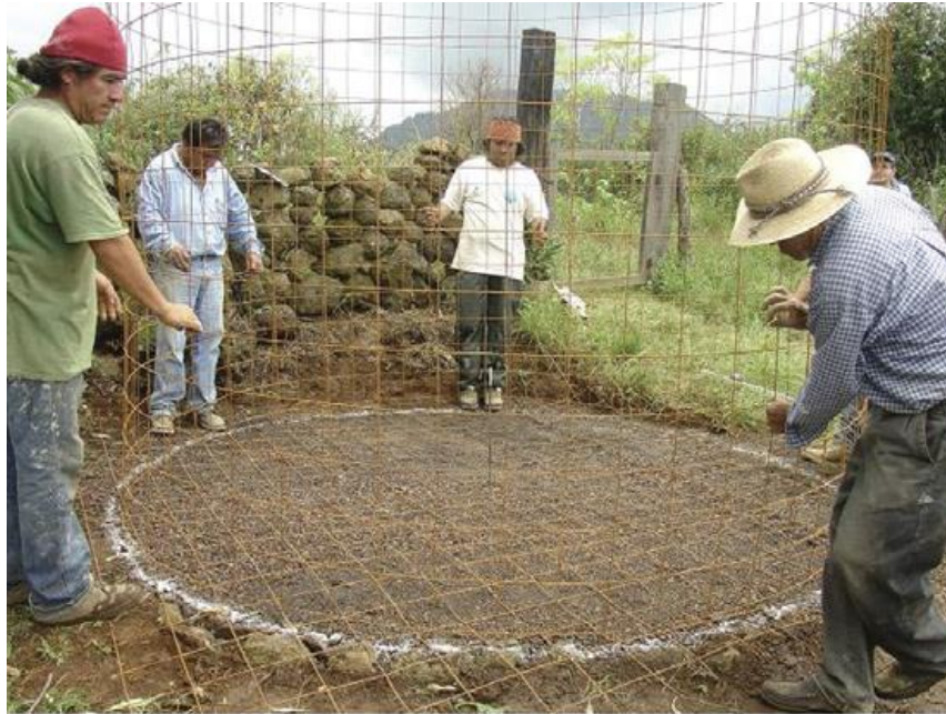
Figura 2.29 Colocación de las mallas del fondo y el cuerpo del tanque (IMTA-UMSH-UAZ, s.f.)
