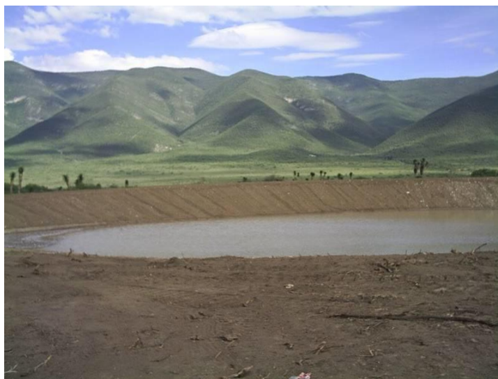
Figura 2.65 Bordo de cortina de tierra compactada
