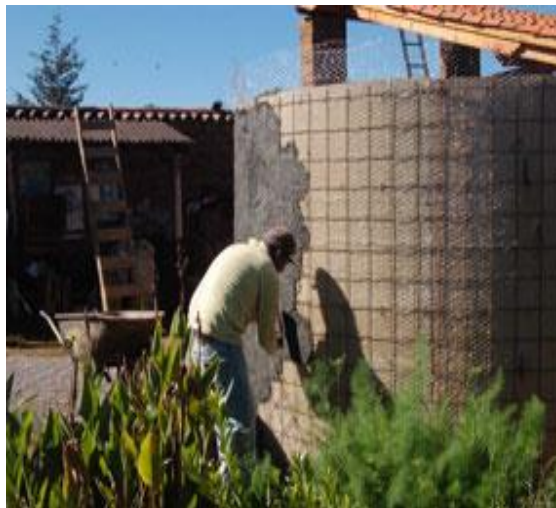
Figura 2.23 Trabajando en el enjarre cubriendo la malla electrosoldada
