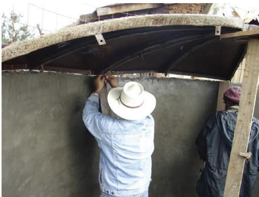
Figura 2.32 Colocación de la cimbra desde el interior del tanque (IMTA-UMSH-UAZ, s.f.)
