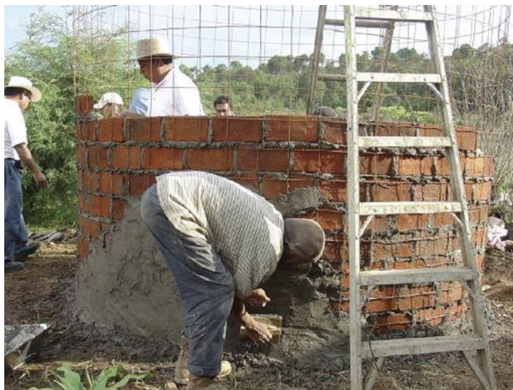
Figura 2.27 Muro de ladrillo tipo capuchino de un tanque de almacenamiento de agua (IMTA-UMSH-UAZ, s.f.)
