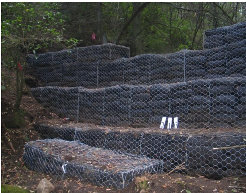
Figura 2.64 Presa de gaviones con geocostales rellenos de tierra
