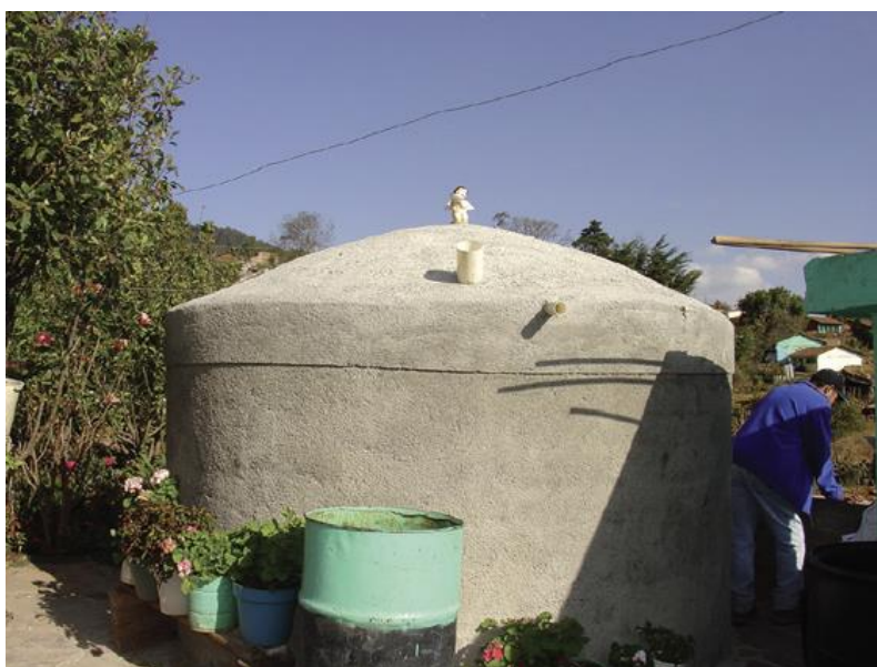
Figura 2.35 Cisterna terminada (IMTA-UMSH-UAZ, s.f.)
