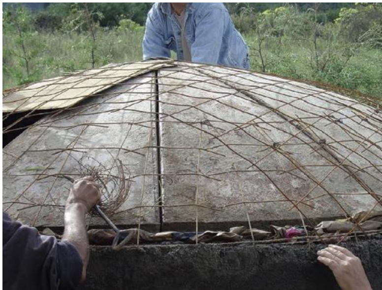
Figura 2.34 Colocación y amarre de malla electrosoldada sobre la cimbra de la tapa (IMTA-UMSH-UAZ, s.f.)
