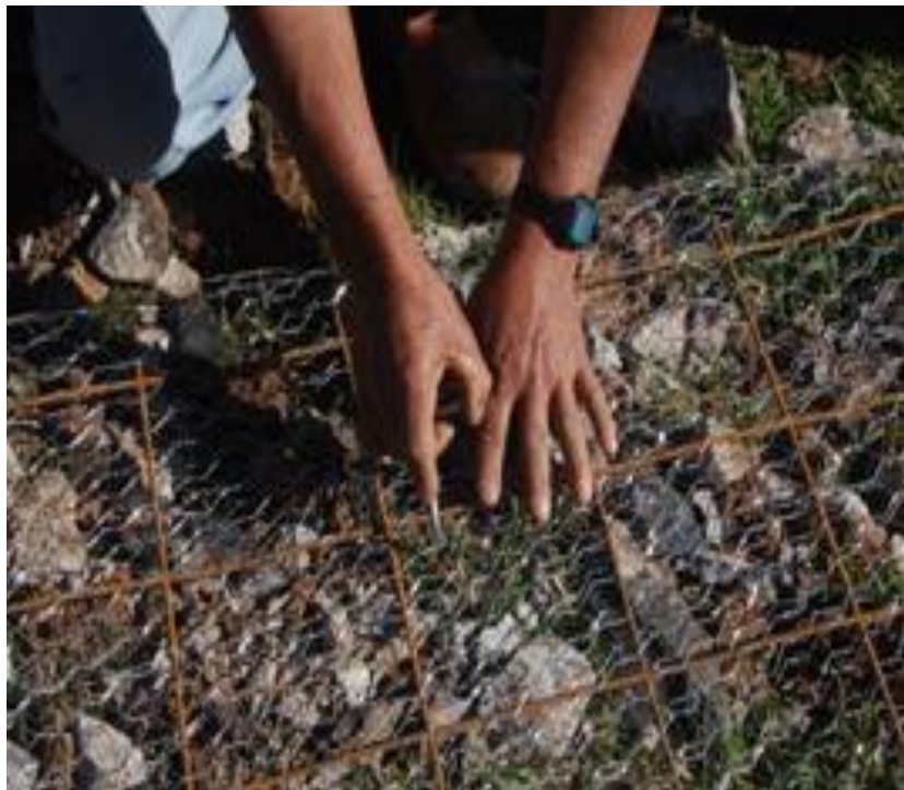
Figura 2.21 Amarrando la malla de gallinero con la malla electrosoldada
