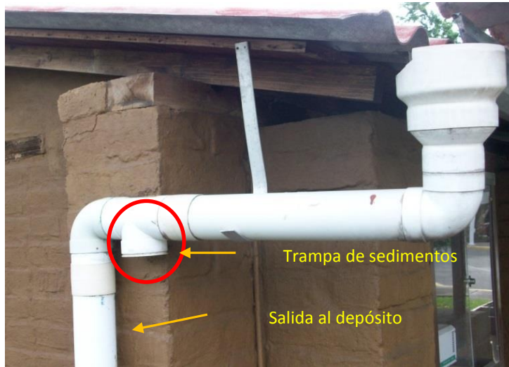
Figura 2.10 Bajante con trampa para drenado de primeras lluvias
