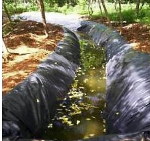
Figura 2.53 Zanja revestida (CATIE, Turrialba, Costa Rica, 2006)
