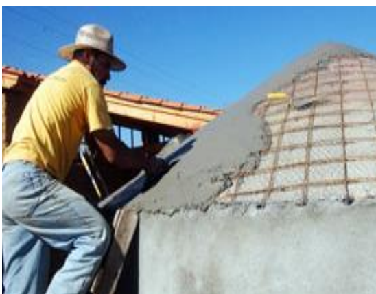
Figura 2.25 Aplicando mezcla de cemento en el techo del tanque
