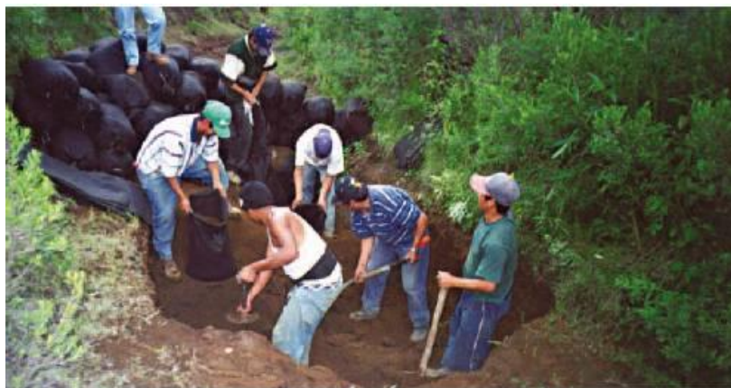
Figura 2.62 Excavación y llenado de geocostales
