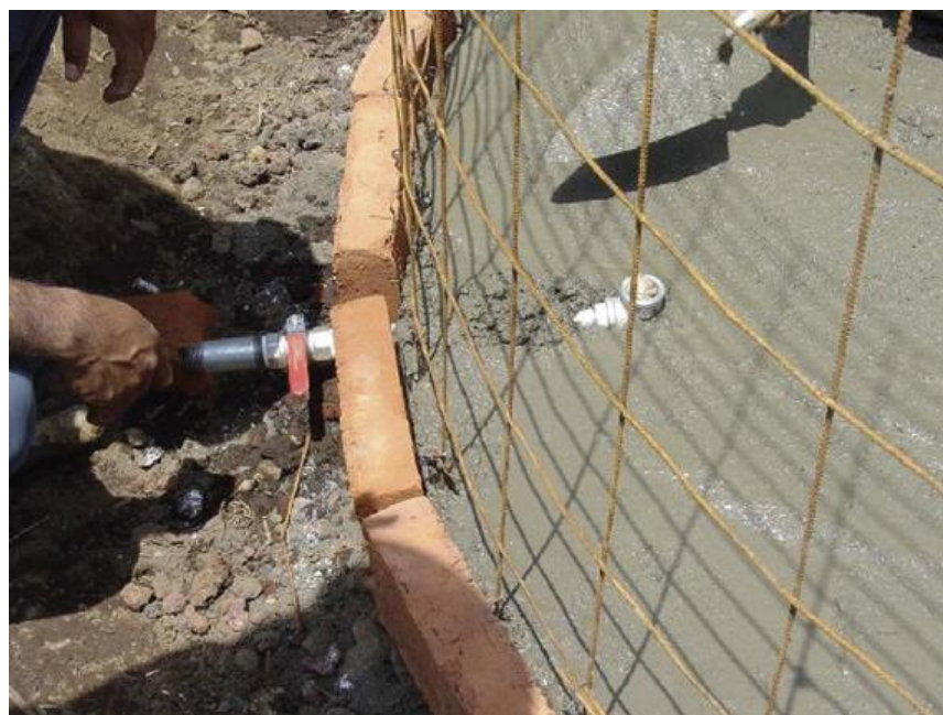
Figura 2.30 Colocación de la tubería para la toma de agua (IMTA-UMSH-UAZ, s.f.)
