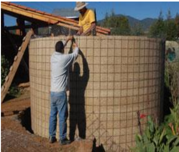
Figura 2.22 Colocando la cimbra interior (triplay) para aplicar cemento
