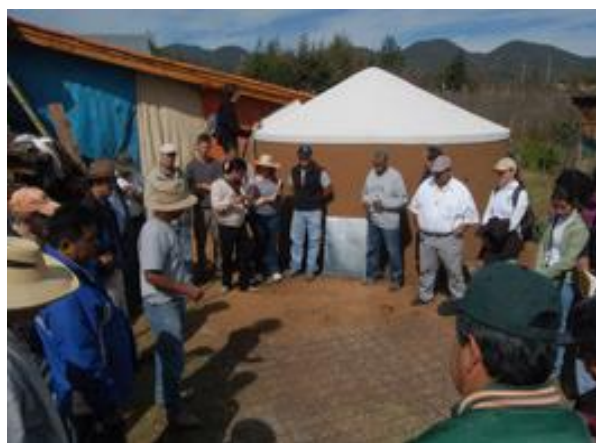
Figura 2.26 Tanque de agua terminado e inicio de la construcción de otro
