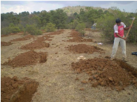
Figura 2.48 Excavación de zanjas trincheras o tinas ciegas
