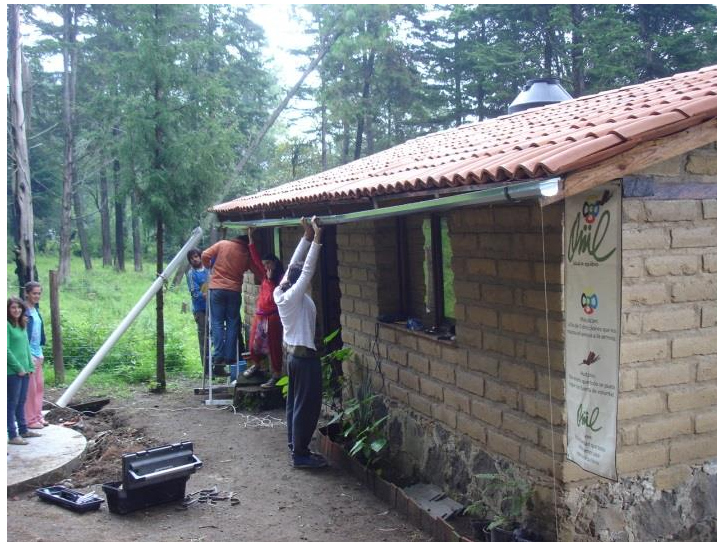
Figura 2.2 Colocando una canaleta y su bajante para almacenar agua de lluvia
