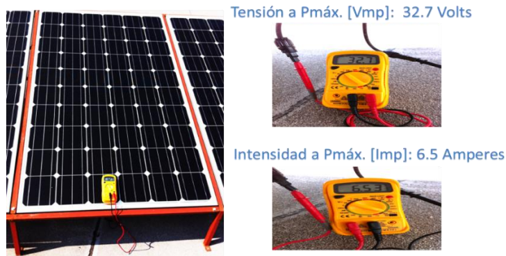
Figura 3.23 Pruebas eléctricas individuales
