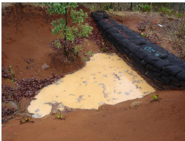
Figura 2.61 Presas de geocostal para retener agua
