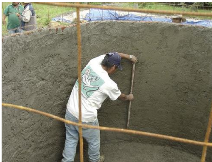
Figura 2.31 Repellido del interior del tanque (IMTA-UMSH-UAZ, s.f.)
