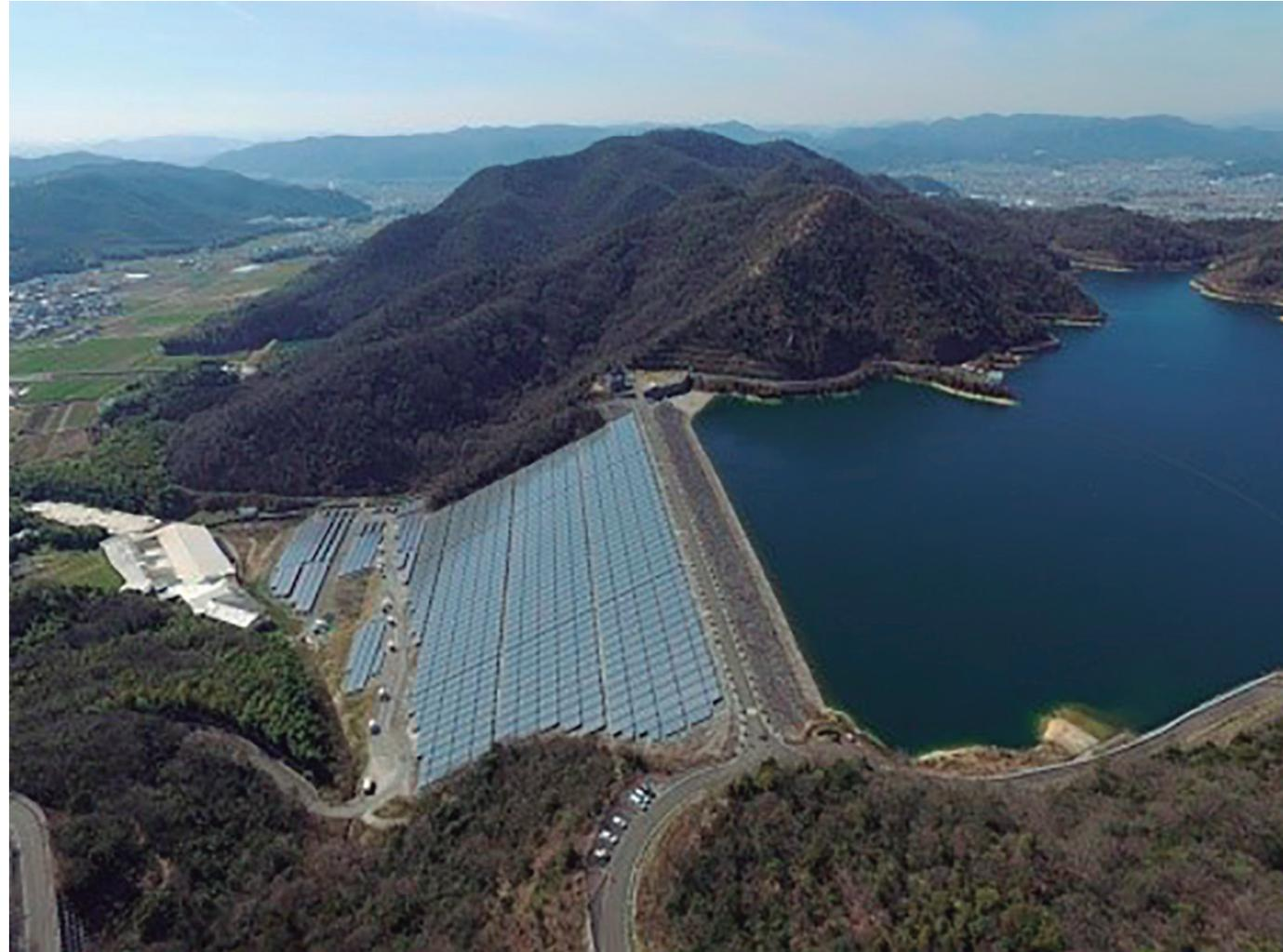
Figura 52. Presa con colocación de paneles solares en cortinas.
