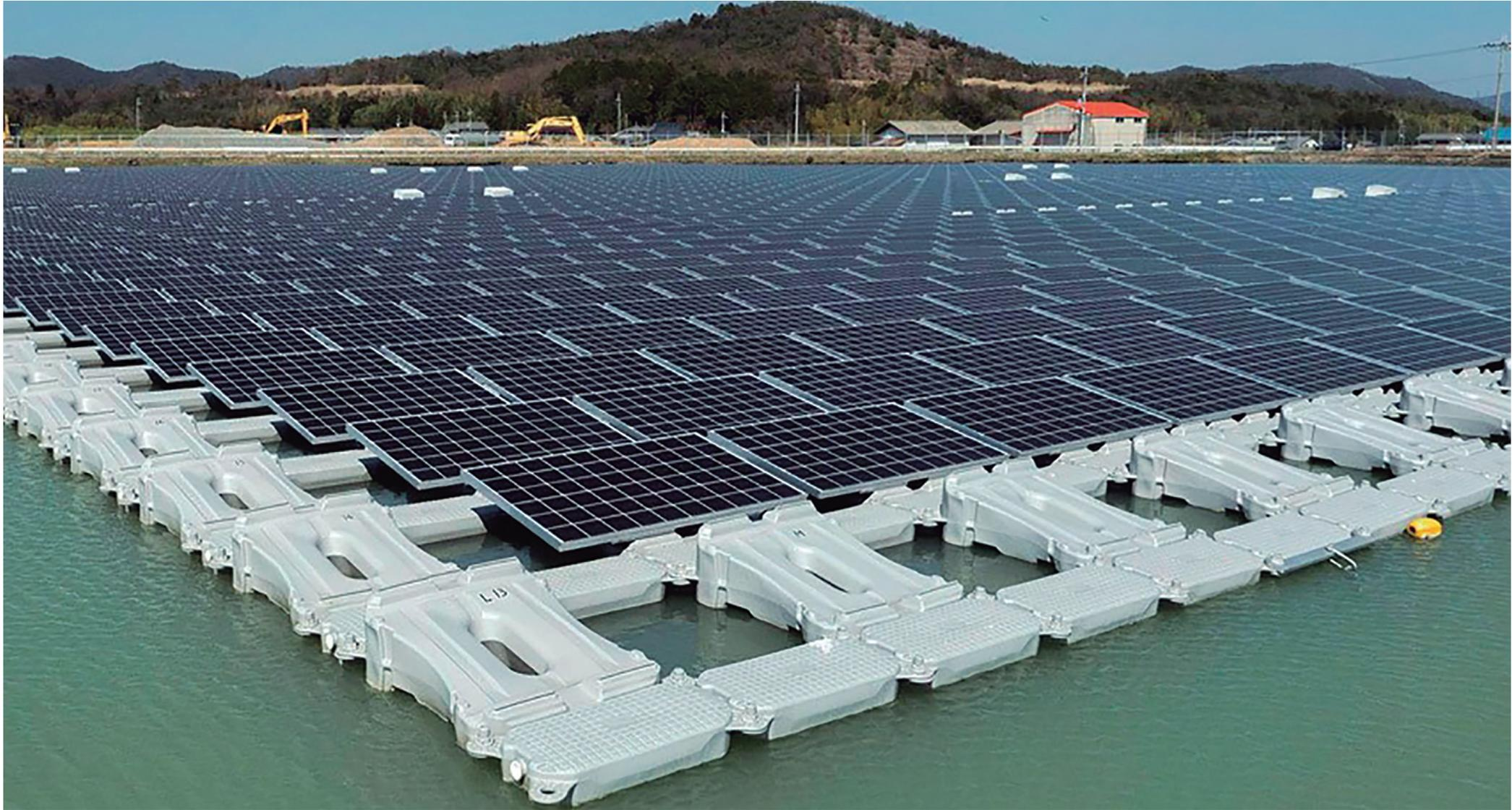
Figura 49. Estructura flotante en una instalación en Huinan, China.
