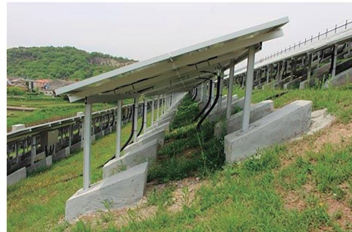
Figura 48. Paneles solares instalados en la cortina de la presa Heiso, Japón.
