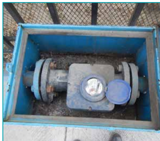
Figura 6.7. Medidor de alto consumidor.
