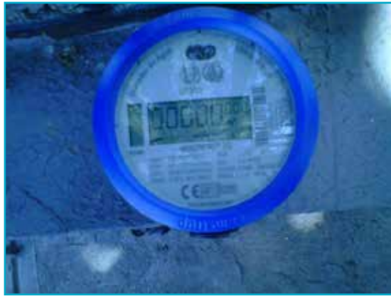
Figura 6.13. Medidor ultrasónico para medición de consumos (medidor inteligente). Clase C.
