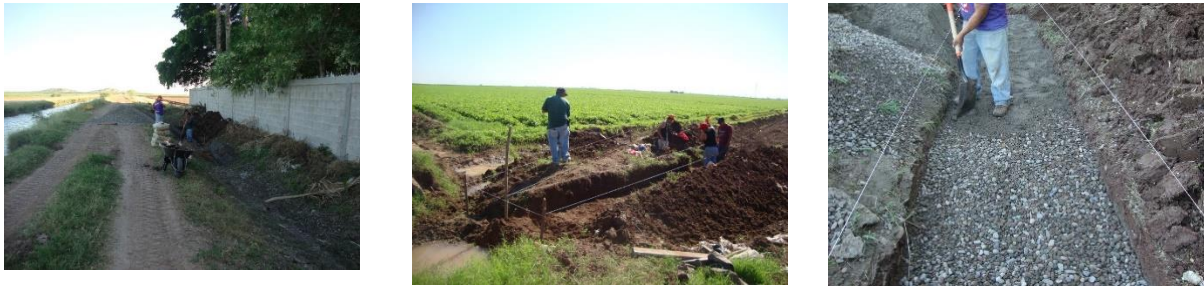
Figura 4.38 Trazo de estructuras con estacas e hilos, excavación de zanjas y colocación de la plantilla de grava y arena apisonada
