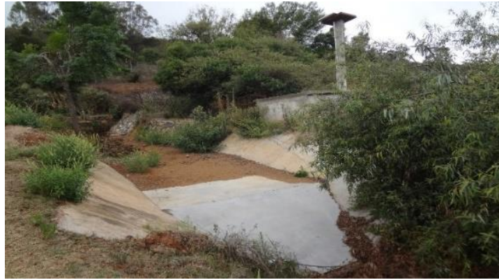
Figura 4.13 Aforador de garganta larga azolvado en la microcuenca Malacate
