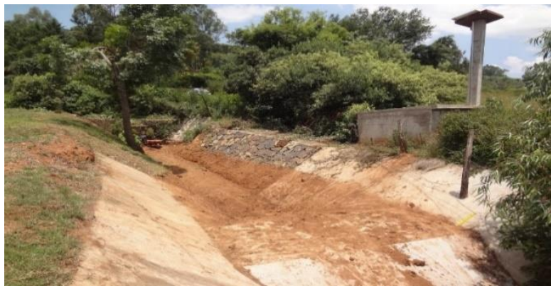
Figura 4.14 Aforador de garganta larga desazolvado en la microcuenca Malacate
