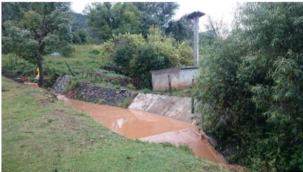
Figura 4.20 Evento de escurrimiento que se presentó en el aforador de la microcuenca Malacate
