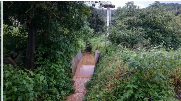
Figura 4.21 Evento de escurrimiento que se presentó en el aforador de la microcuenca Ichupio
