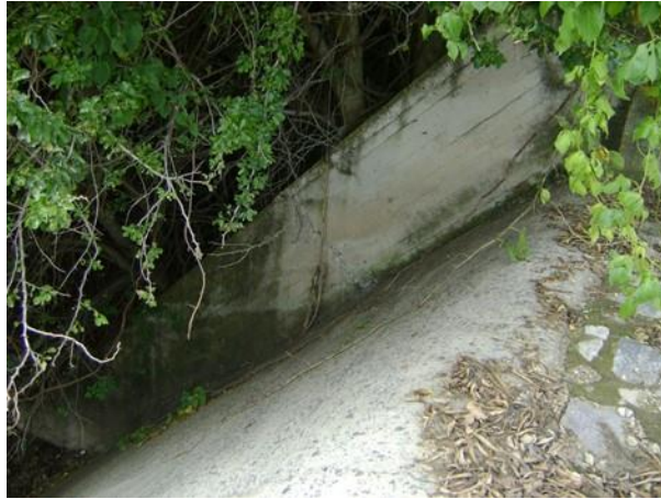
Figura 5.42 Muro de encauce en la margen derecha
