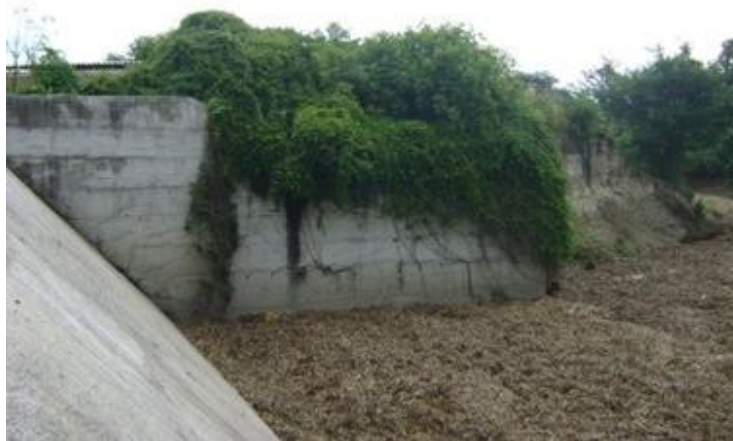
Figura 5.39 Detalle del vertedor de demasías en la presa Los Sabinos
