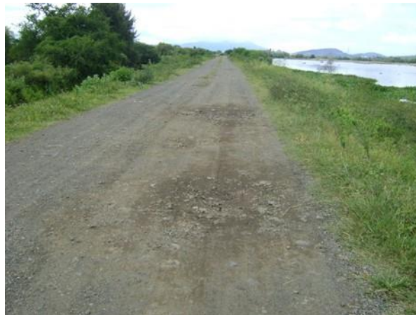
Figura 5.36 Detalle del ancho de la corona de la presa Los Sabinos
