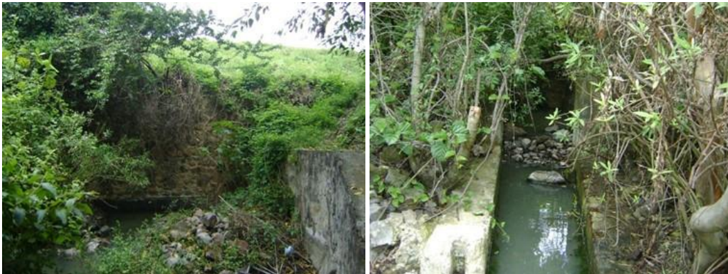
Figura 5.45 Detalle de la salida de la obra de toma
