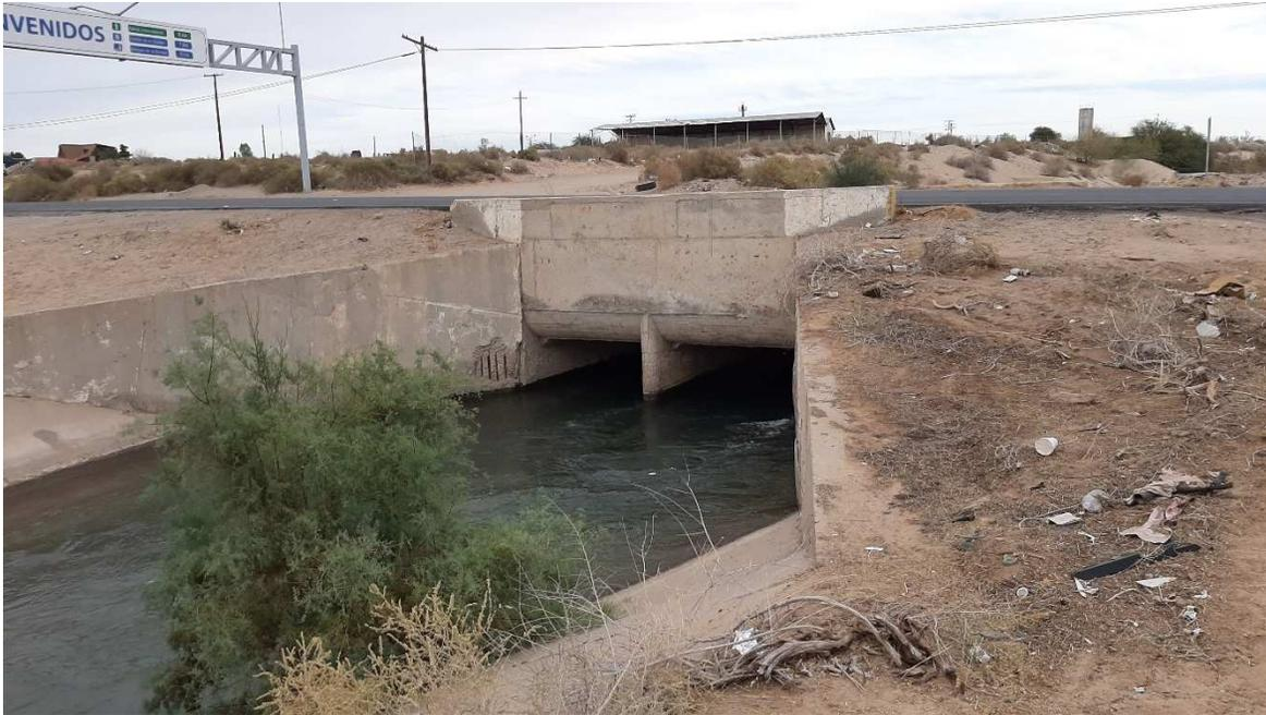
Foto A.1 Cruce de la carretera en la sección del canal del KM 2+277 y KM 2+293
