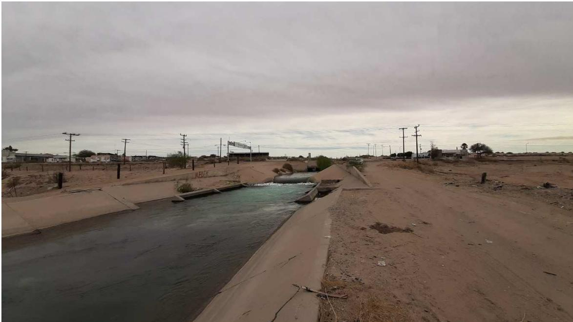
Foto A.4 Vista hacia aguas arriba de la Caída 5 del canal en el KM 2+240 y zona donde se colocaría la llegada a la turbina y su descarga en el tanque dissipador de energía.
