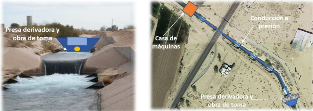
Figura 8.1. Propuesta 1. Presa derivadora en 1era caída en planta
