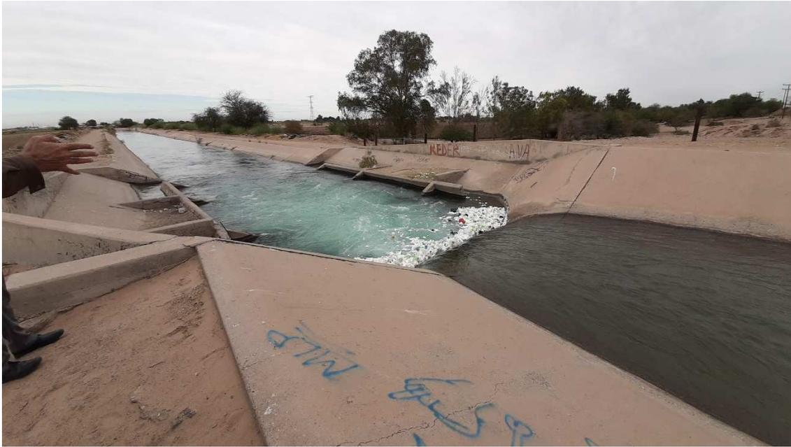
Foto A.3 Caída 5 del canal en el KM 2+240 y zona donde se colocaría la llegada a la turbina y su descarga en el tanque dissipador de energía.
