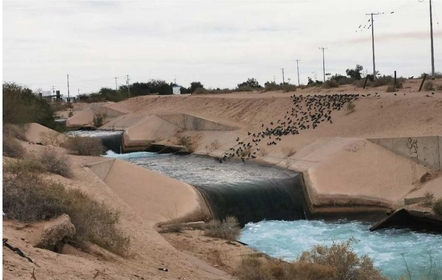
**Figura 2.4 Tercera caída y su tanque de amortiguamiento del Canal San Luis**
