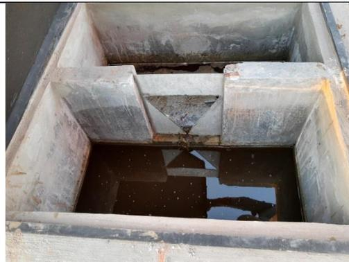
(D7) Vertedor triangular con lámina de acero inoxidable instalado en registro 2.
