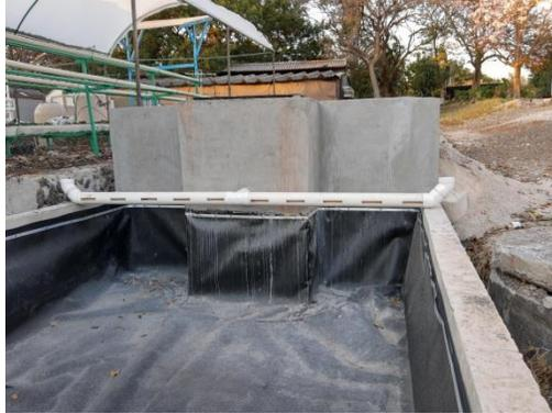
Construcción de registro 3, con cabezal de PVC ranurado.
