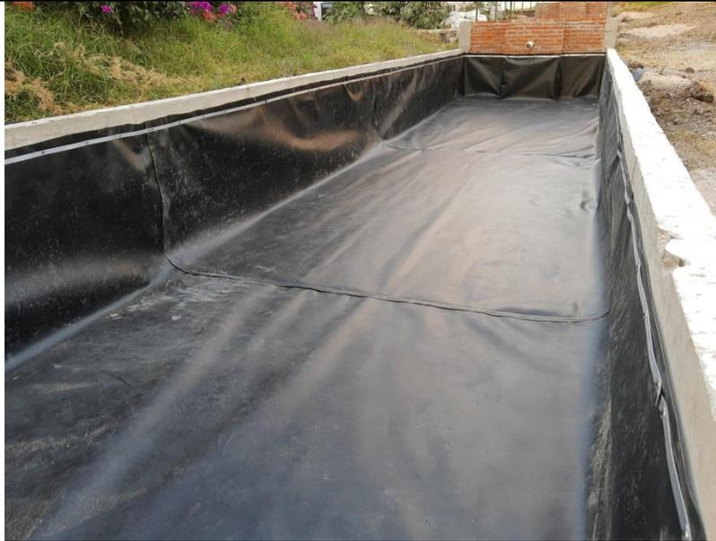
(B2) Instalación de la geomembrana en el humedal de pulimento.
