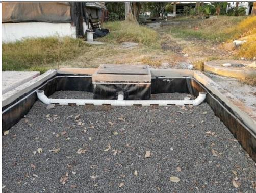
(D6) Registro 2 con cabezal de PVC con ranuras.
