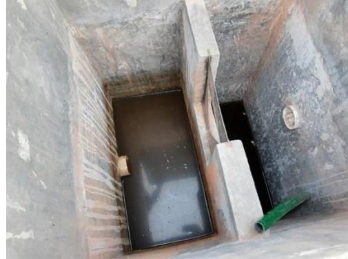
Vertedor triangular con lámina de acero y manguera flexible para controlar altura del agua residual.
