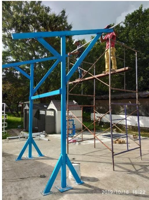
Ilustración 44 Armado de la estructura.
