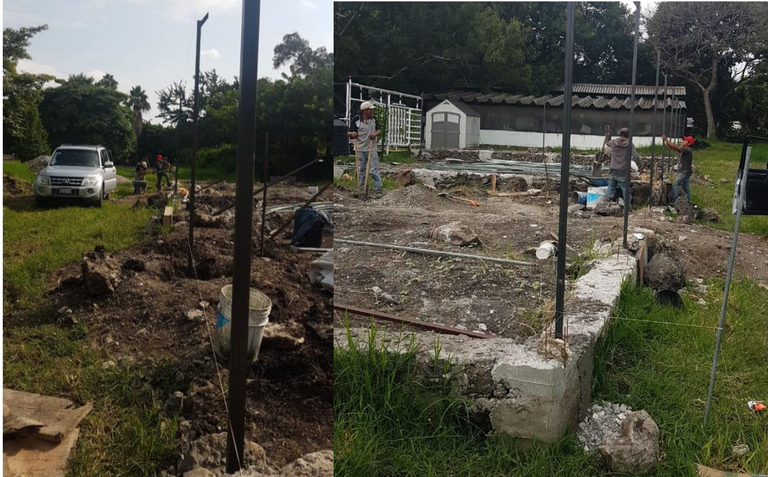
Ilustración 23 Colocación de tubería PTR fijada con cemento.
