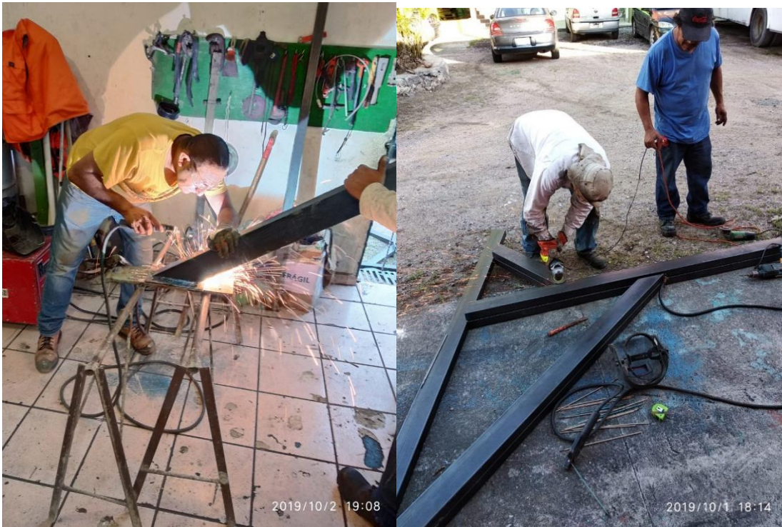
Ilustración 38 Proceso de soldadura.
