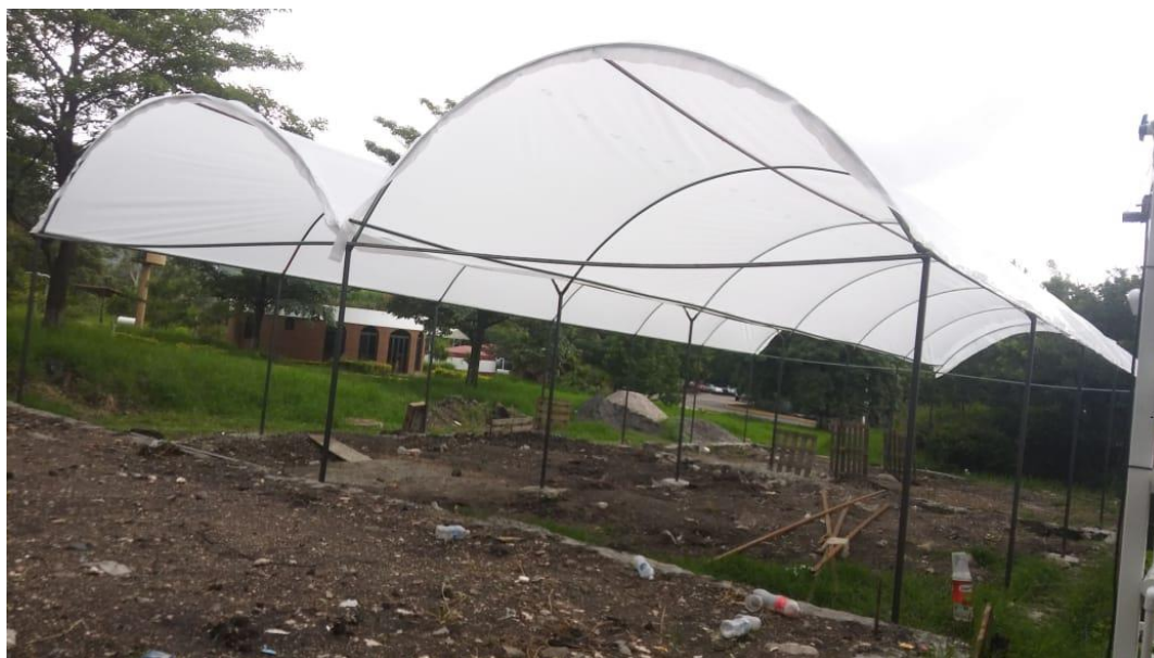
Ilustración 30 Vista final de la instalación de arco-techo
