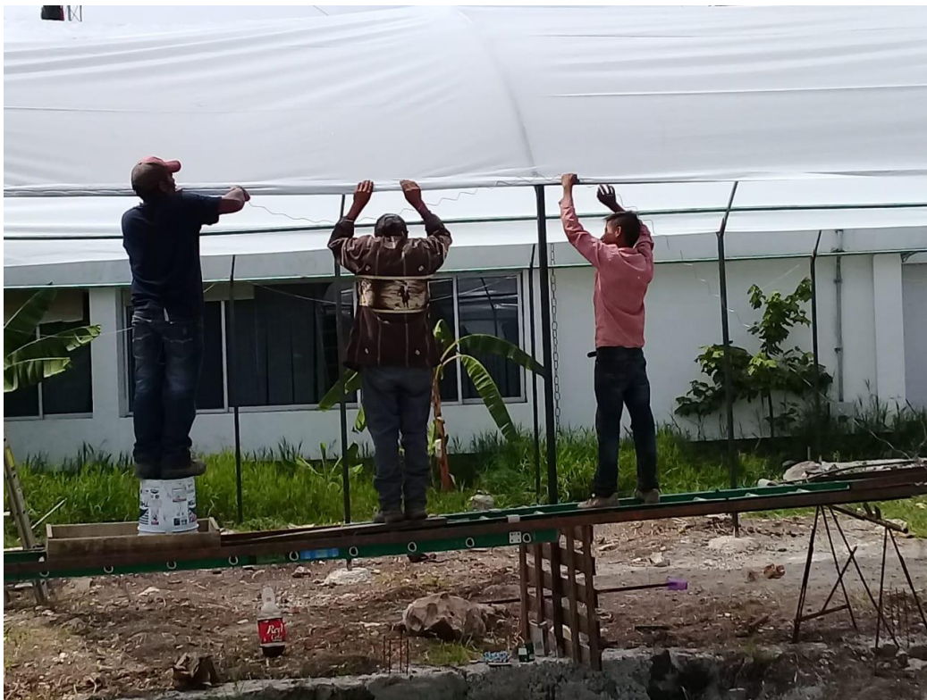
Ilustración 29 Colocación de alambre Zig Zag para fijación de plástico.
