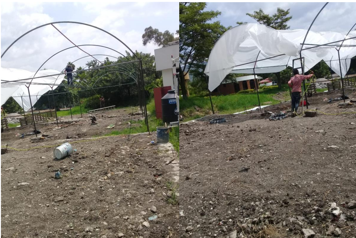
Ilustración 27 Colocación de plástico.
