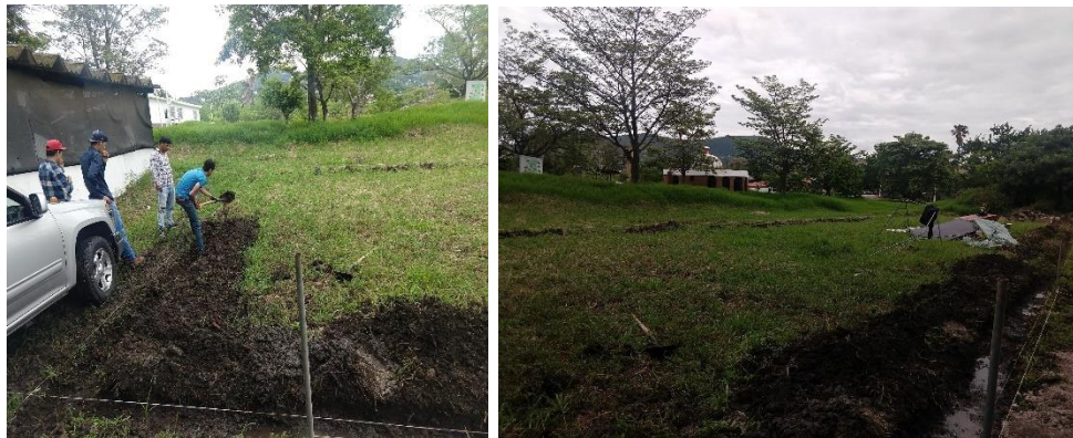
Ilustración 32 Excavación de zanjas para mampostería
