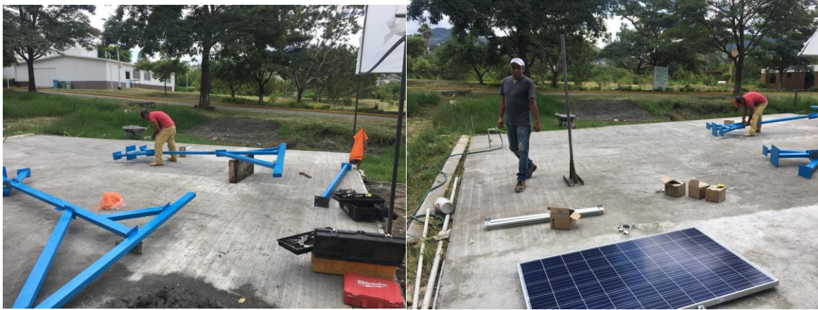
Ilustración 42 Pre armado de la estructura.
