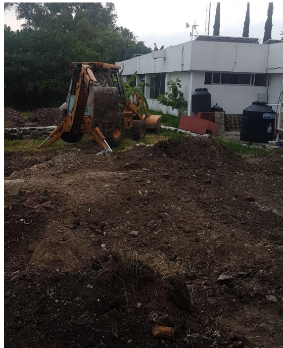
Ilustración 19 Relleno y nivelación de piso
