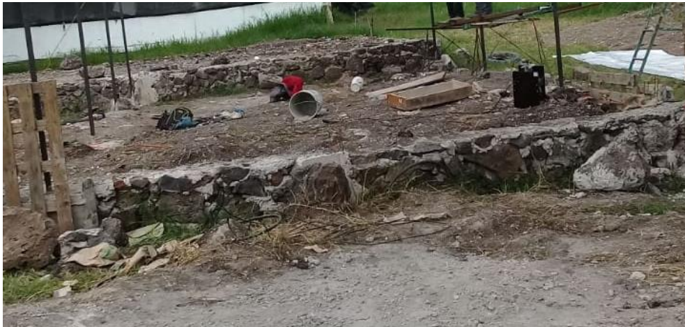
Ilustración 18 Construcción de mampostería
