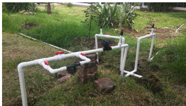
Ilustración 16 Venturi instalado
