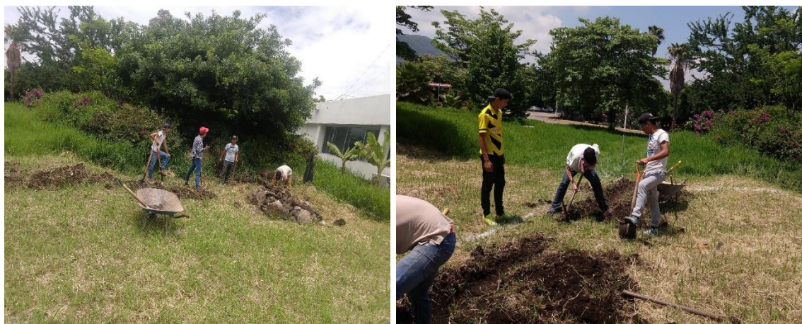
Ilustración 17 Trazo y excavación de zanjas
