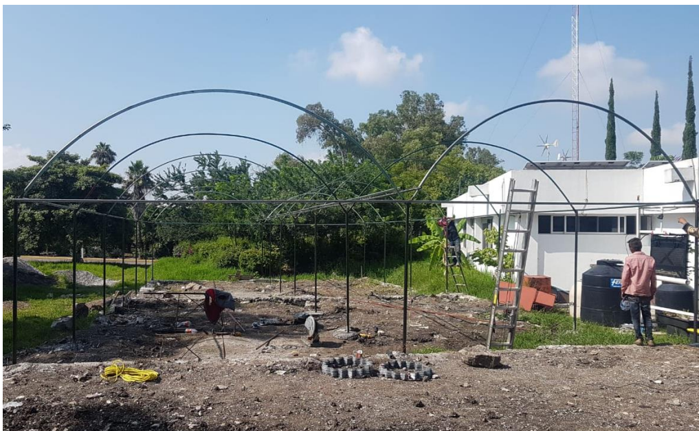
Ilustración 25 Fijación de tuberías para arco-techo
