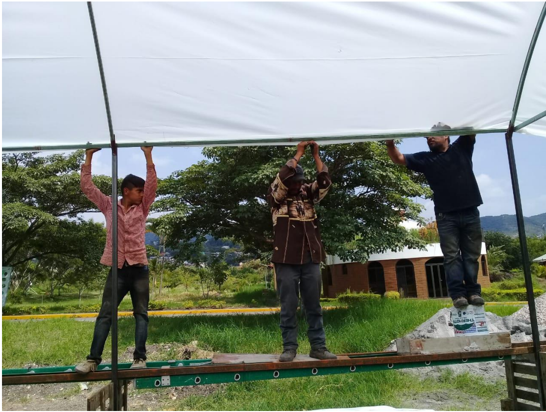
Ilustración 28 Colocación de plástico en arco-techo.
