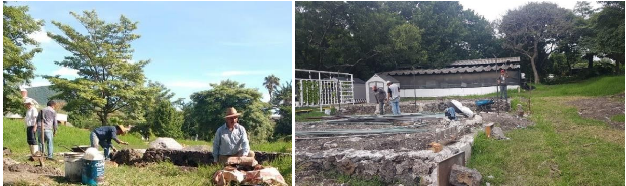
Ilustración 34 Construcción de mampostería
