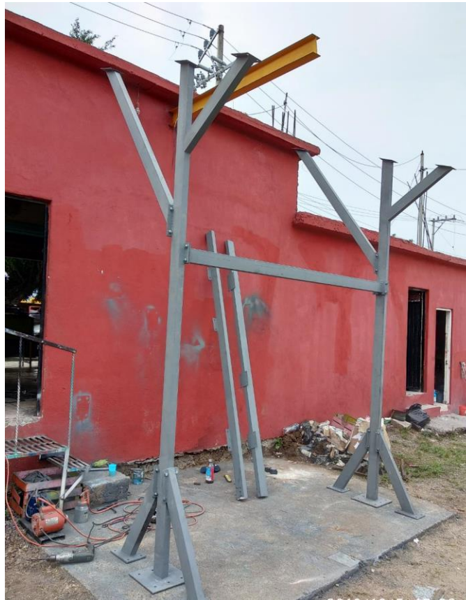
Ilustración 40 Pre ensamblado de la estructura para paneles fotovoltaicos con primer.
