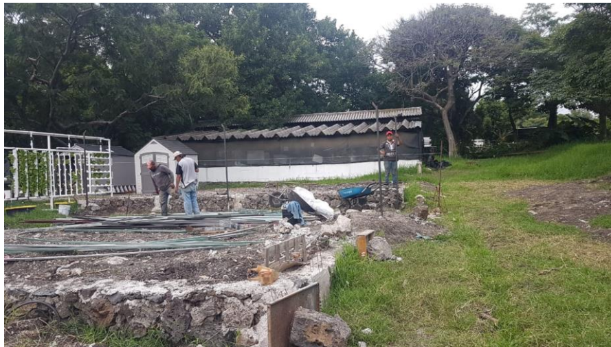
Ilustración 20 Suministro de tubería PTR y Zintro para armado de arco techo.
