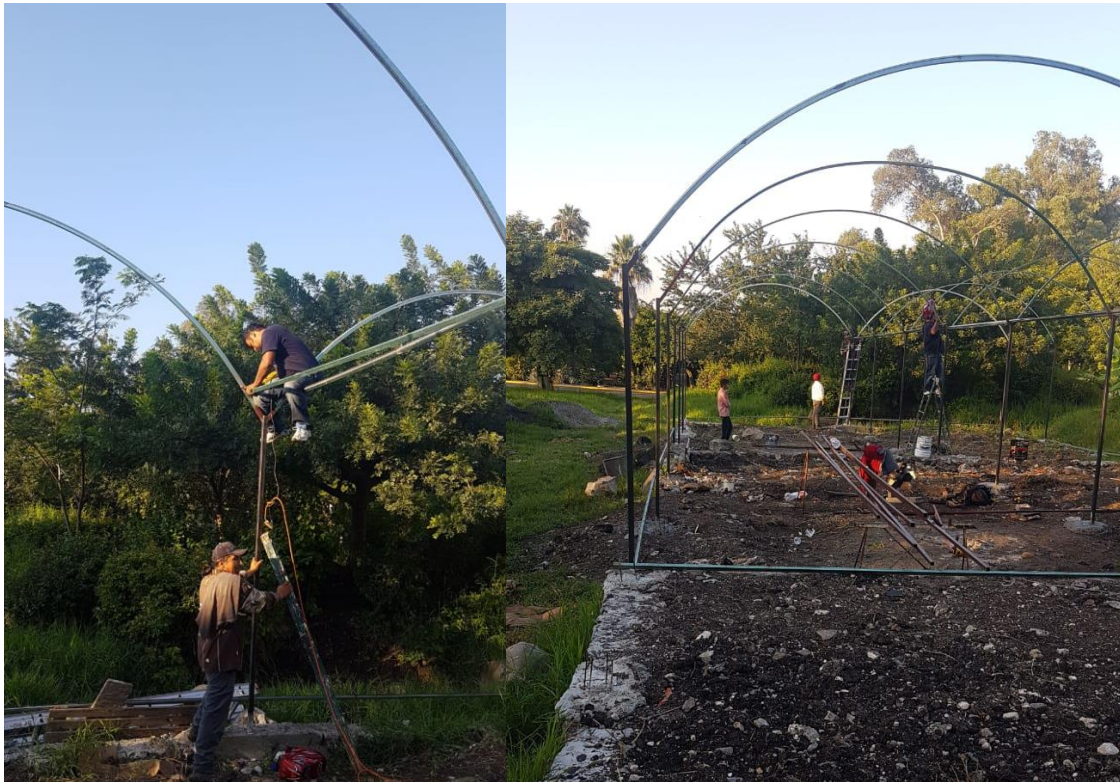
Ilustración 24 Colocación de tubería arco-zintro
