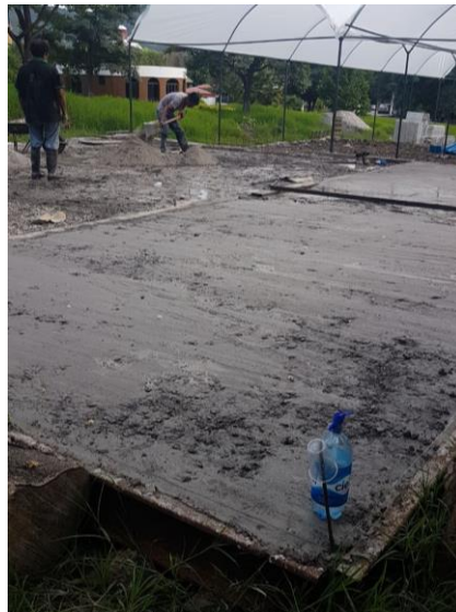
Ilustración 35 Construcción de plancha de concreto para colocación de sistema desalinizador
