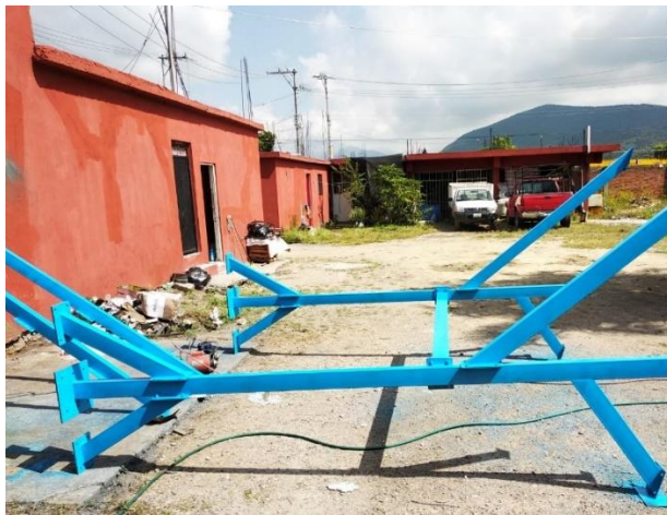
Ilustración 41 Pintura final de la estructura.
