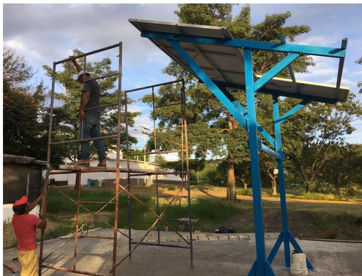
Ilustración 45 Instalación de paneles fotovoltaicos.
