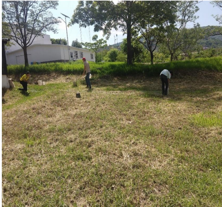
Ilustración 31 Trazo para excavación de zanjas
