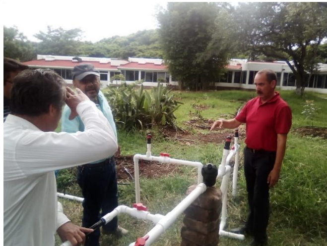
Ilustración 15 Explicación del funcionamiento para puesta en marcha
