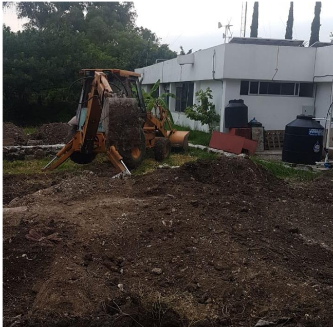
Ilustración 33 Relleno y nivelación de área para plancha de concreto
