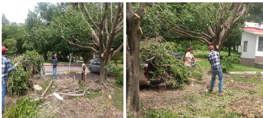
Ilustración 2 Limpieza de área para plantación de aguacate
