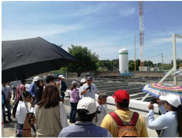
Foto 4.20 Recorrido por la PTAR
