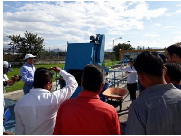
Foto 4.37 Recorrido por la PTAR
