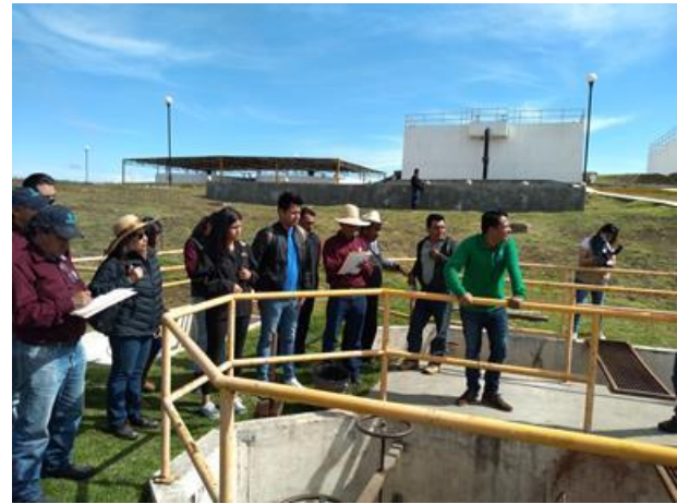
Foto 4.123 Recorrido por la PTAR
