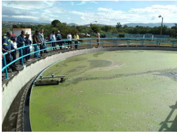
Foto 4.38 Recorrido por la PTAR
