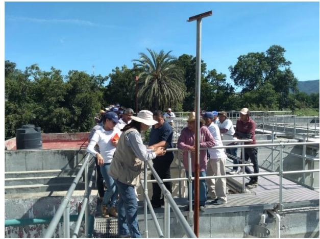
Foto 4.117 Recorrido por la PTAR
