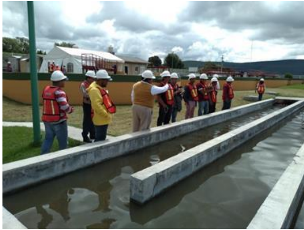
Foto 4.102 Recorrido por la PTAR
