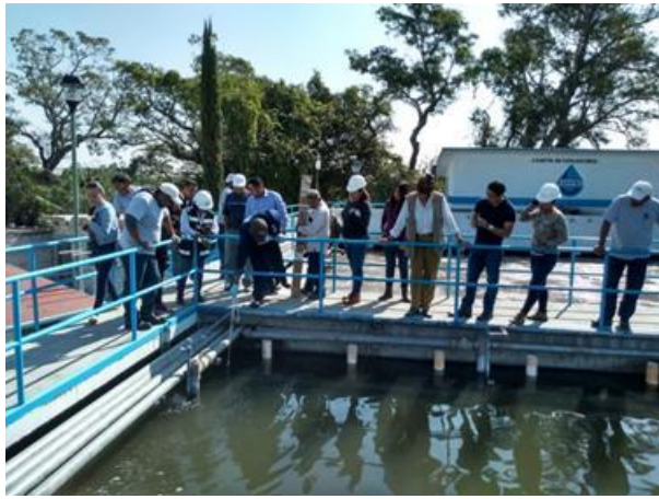
Foto 4.70 Recorrido por la PTAR
