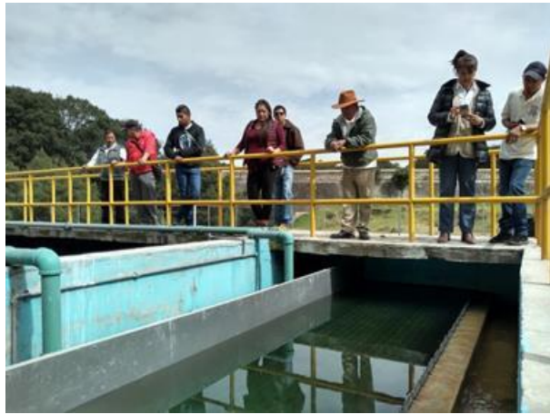
Foto 4.164 Recorrido por la PTAR
