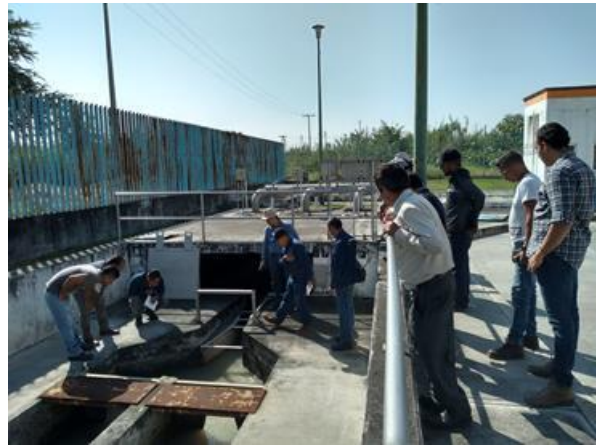
Foto 4.85 Recorrido por la PTAR
