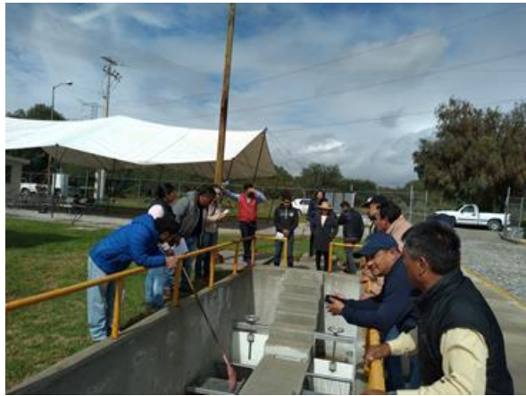
Foto 4.138 Recorrido por la PTAR
