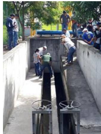
Foto 4.45 Recorrido por la PTAR
