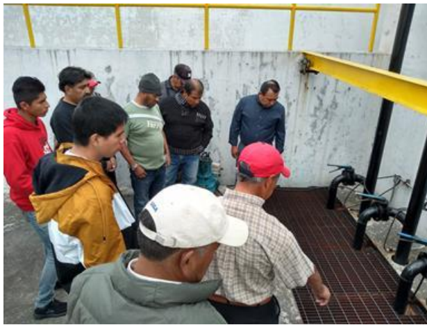
Foto 4.130 Recorrido por la PTAR
