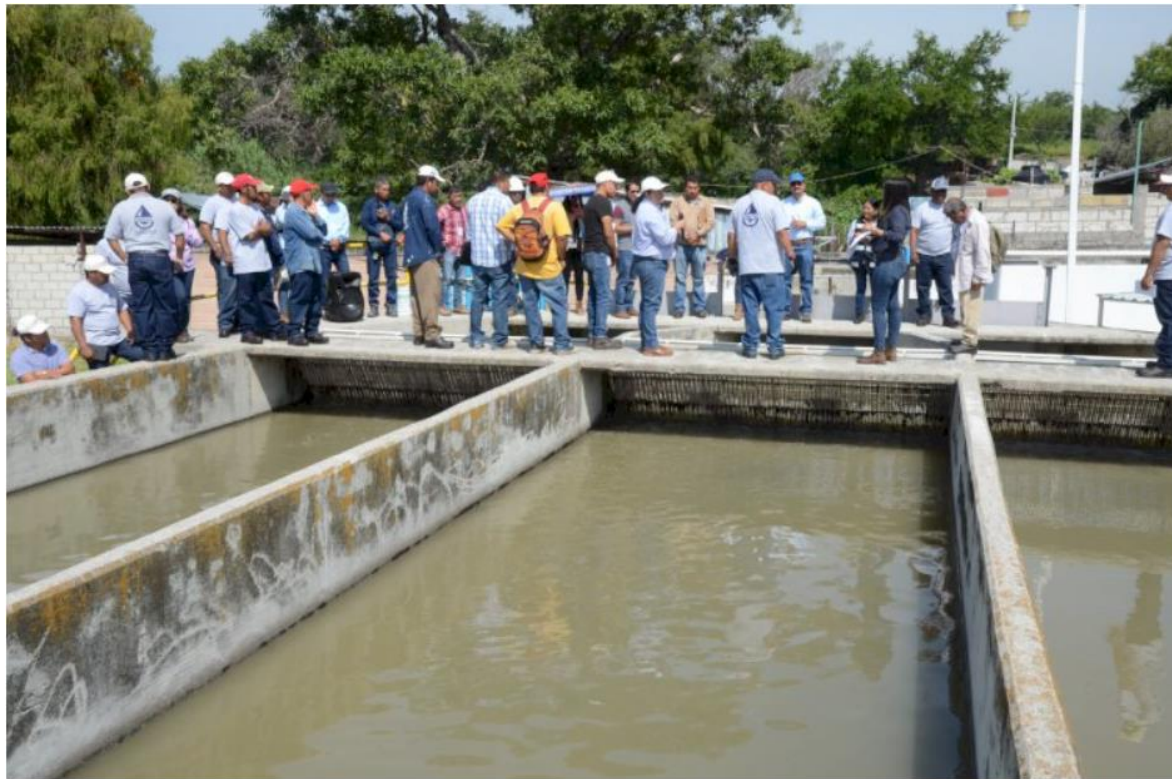
El IMTA realizó un curso de capacitación para operadores de Plantas de Tratamiento de Aguas Residuales.
