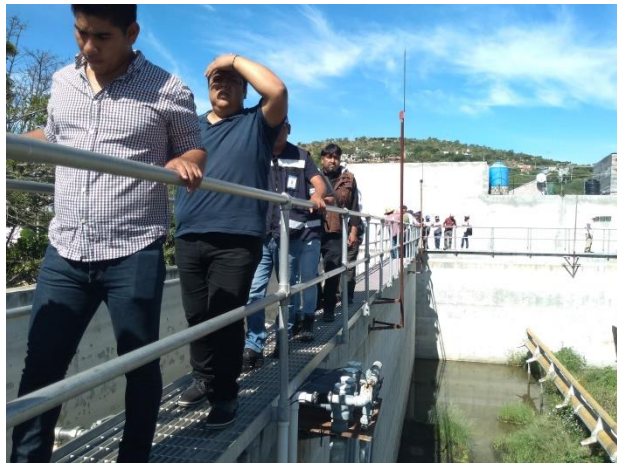
Foto 4.118 Recorrido por la PTAR
