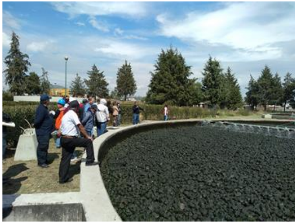
Foto 4.172 Recorrido por la PTAR
