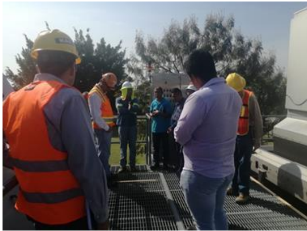
Foto 4.78 Recorrido por la PTAR
