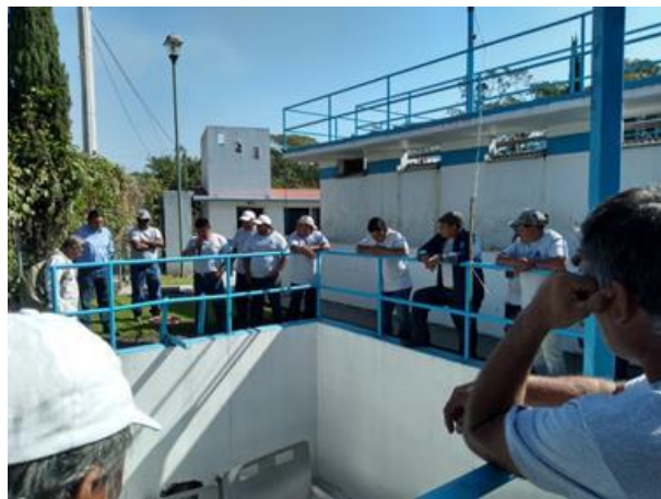
Foto 4.69 Recorrido por la PTAR
