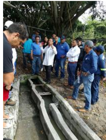
Foto 4.13 Recorrido por la PTAR
