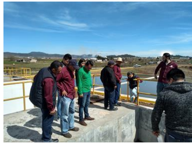
Foto 4.124 Recorrido por la PTAR
