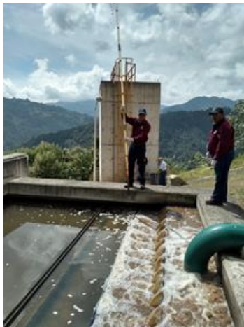
Foto 4.94 Recorrido por la PTAR
