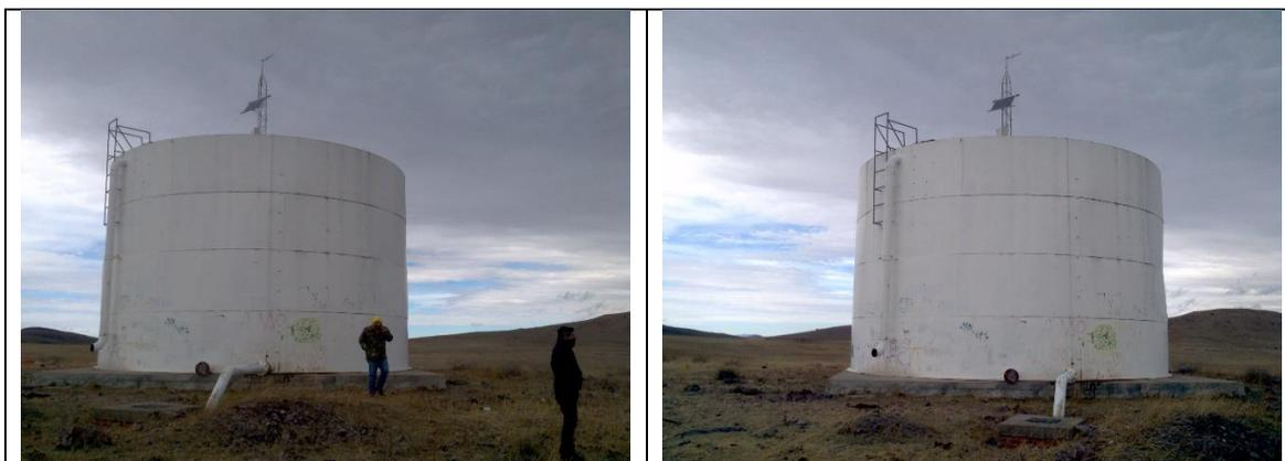
**Ilustración 18 Tanque metálico #2 en operación de una capacidad de 700 m<sup>3</sup>.**
