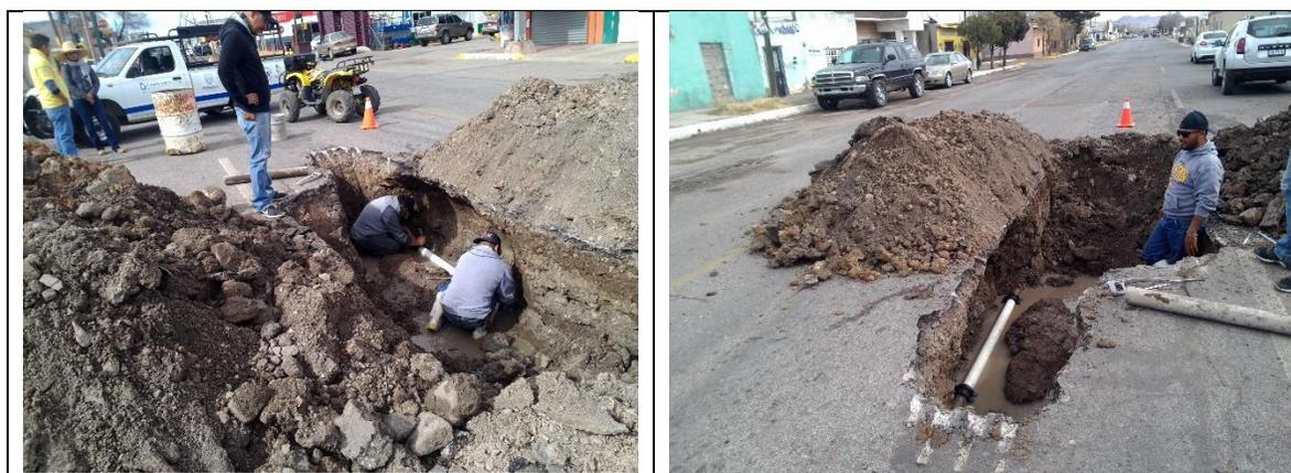
**Ilustración 58 Trabajos de reparación de la fuga con tubería de PVC.**
