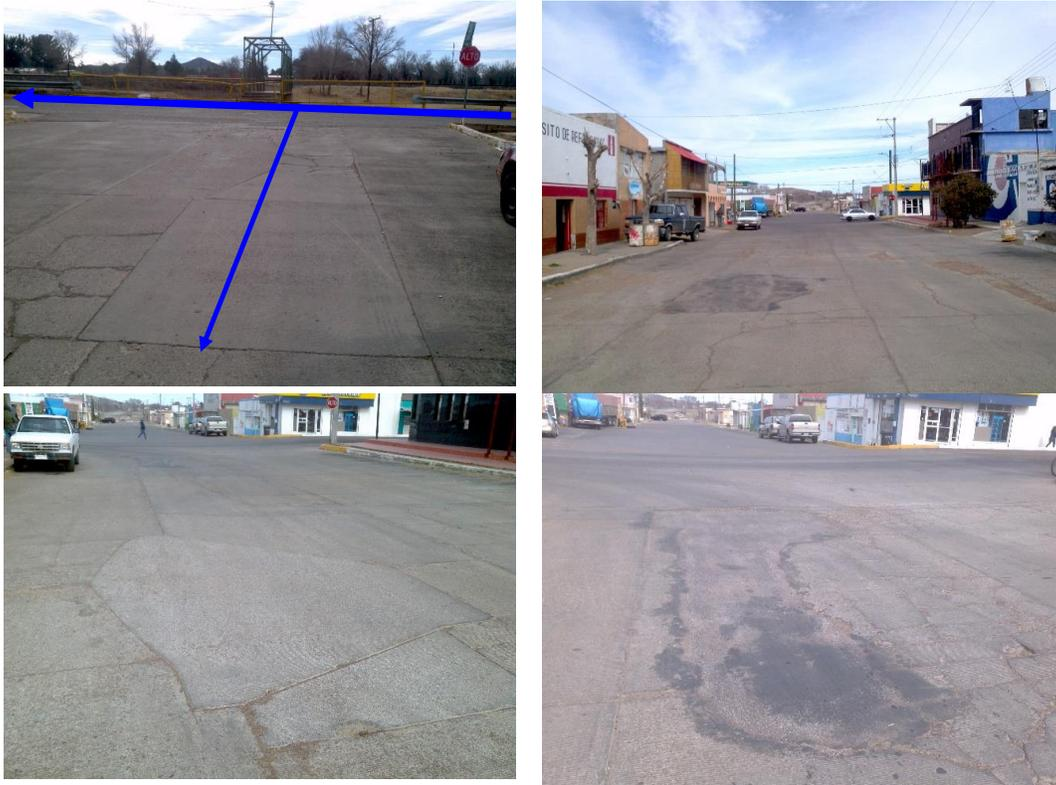
**Ilustración 31 Calle Francisco J. Mina con 3 sitios de reparación de fugas en tuberías.**
