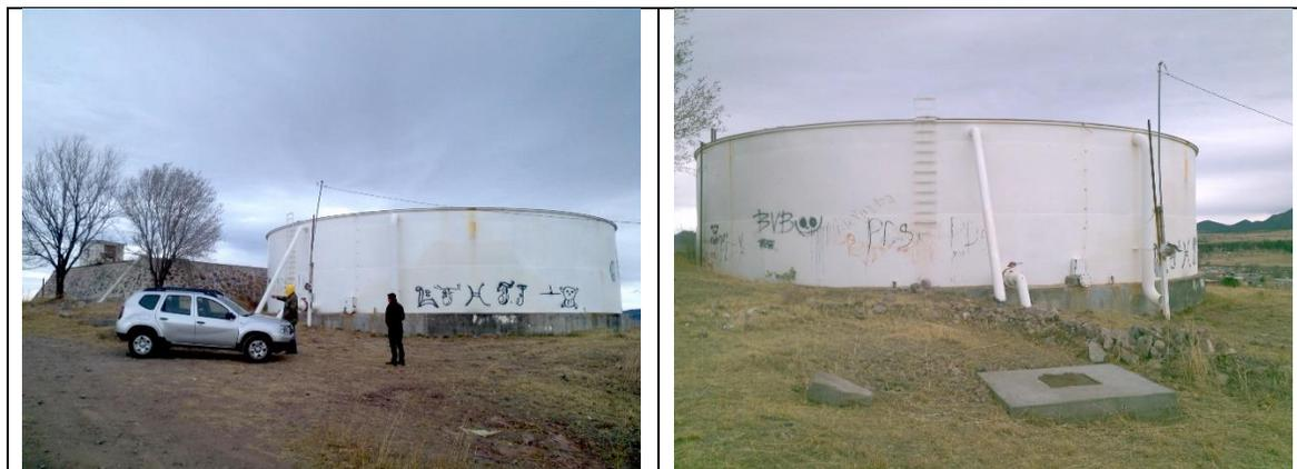
**Ilustración 16 Tanque de mampostería fuera de servicio. El metálico de 1000 m<sup>3</sup> operando.**
