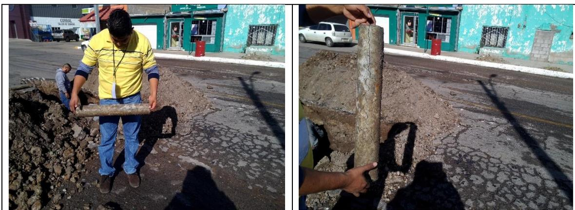
**Ilustración 54 Fuga en tubería de 3" diámetro, asbesto cemento, con una fisura de 60 cm.**
