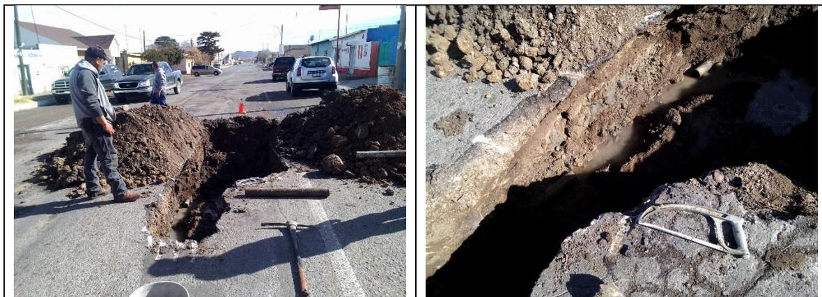
**Ilustración 55 Zanja con profundidad de 1.40 metros y profundidad al tubo 1.20 metros.**
