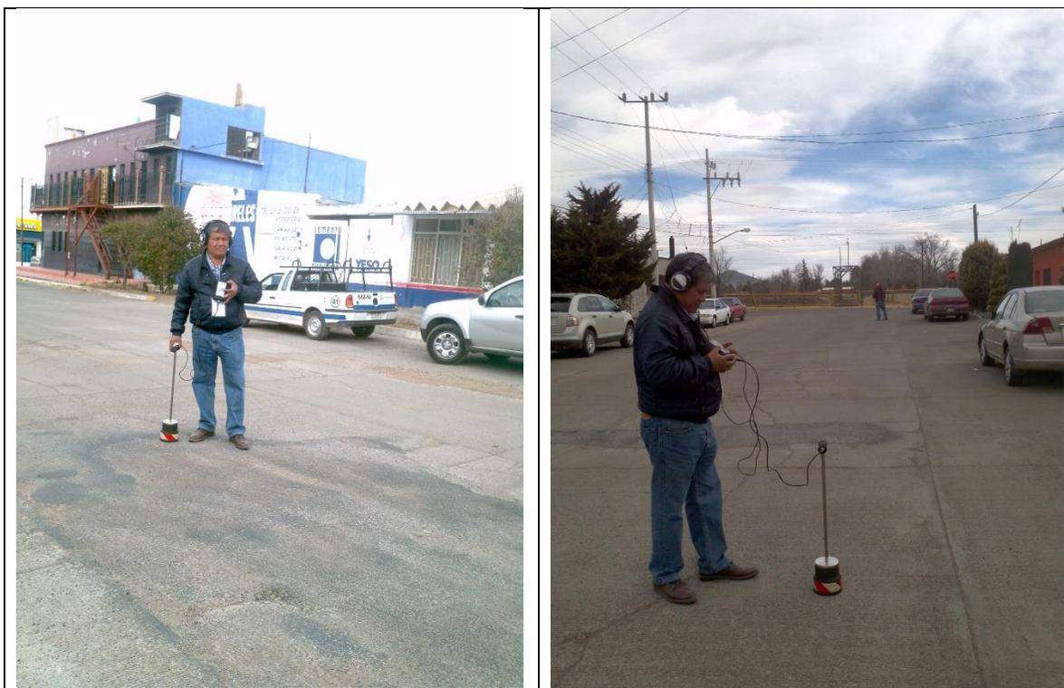
**Ilustración 53 Conjuntamente JRAS-IMTA revisando tuberías con equipos detectores de fugas.**
