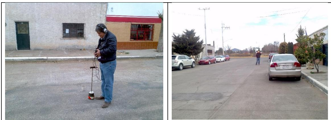
**Ilustración 52 Localización de fugas con equipo electro acústico ambas JRAS-IMTA.**
