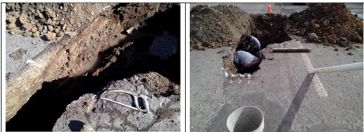
**Ilustración 57 Longitud del tramo a reparar 1.40 metros con tubería de PVC.**
