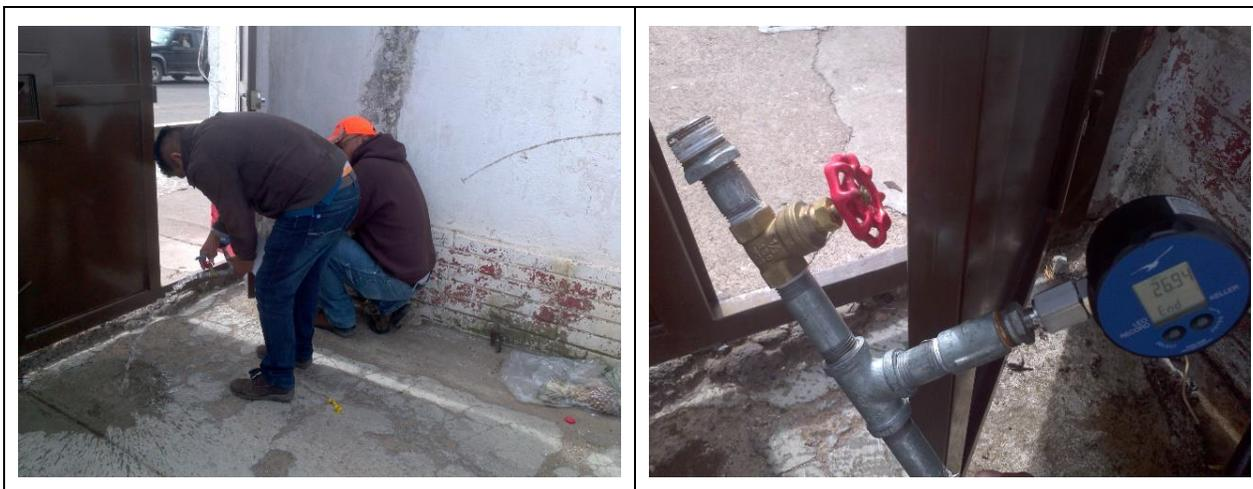
**Ilustración 42 Sitio 8 con caída de presión; día siguiente presión 26.94 M.C.A. no hay fuga.**
