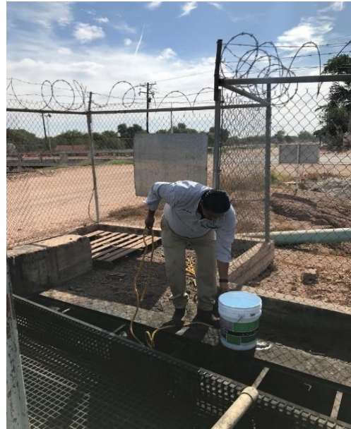
Pozo PP 3 y 4
