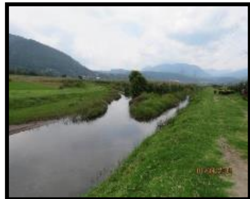
Foto 5.1.4.11.- Confluye el canal con el río Amanalco.
