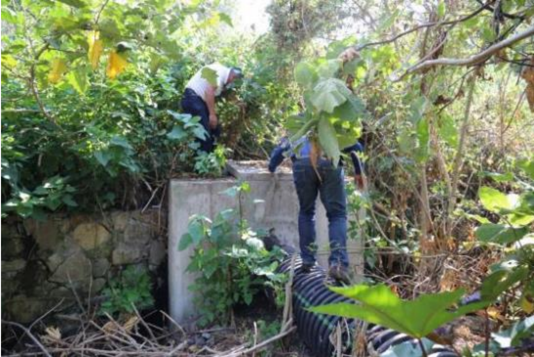
Foto 5.2.26.- Primero de cuatro módulos de la planta de tratamiento de San Francisco. Punto de llegada del colector central.
