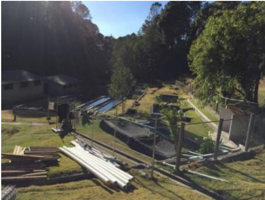
Foto 5.2.13.- Instalaciones del rancho del Sr. Guadalupe Mondragón.
