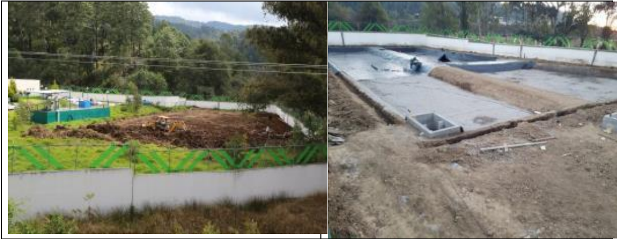
Fotos 5.4.38 y 5.4.39- Aspectos de la instalación del humedal artificial en el hospital del IMSS en Amanalco.
