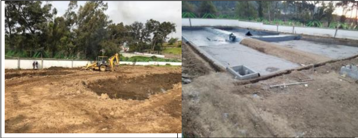
Fotos 5.2.43 a 5.4.48- Aspectos de la instalación del humedal artificial en el hospital del IMSS en Amanalco.
