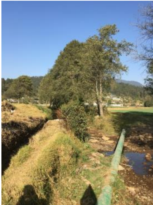
Foto 5.2.2. Colector marginal procedente de San Mateo en el cruce del río en la localidad de San Sebastián Chico (a 100 metros del terreno de la Sra. Susana Contreras Vera).
