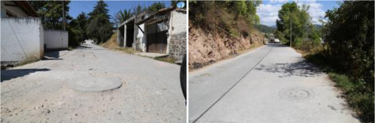
Fotos 5.4.23 y 5.4.24- Colector principal de drenaje de la 1ª Sección de San Miguel Tenex-tepec.
