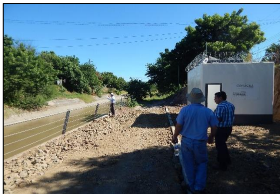
Ilustración 31: Caseta de aforo del canal principal “Rosales”.
