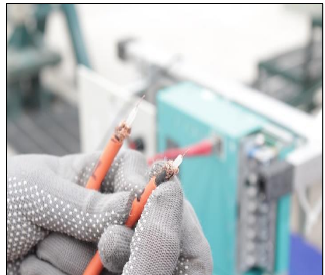
Ilustración 65: Instalación del cable de comunicación en el modulador del equipo tiempo de travesía.
