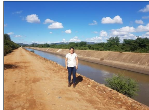
Ilustración 87: Canal "HUAMAYA" perteneciente al DR 010 de CONAGUA, estación 5+000, ubicación: Culiacán, Sinaloa.
