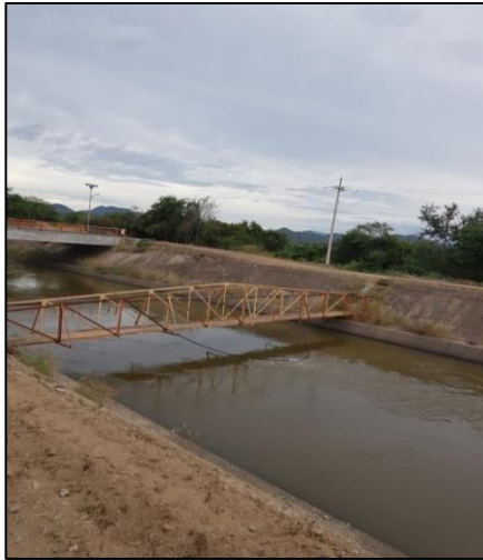
Ilustración 84: Estación para aforar el gasto, con técnicas de medición NO fijas como el ATT de barquito, el molinete o sensores ultrasónicos Doppler no invasivos.
