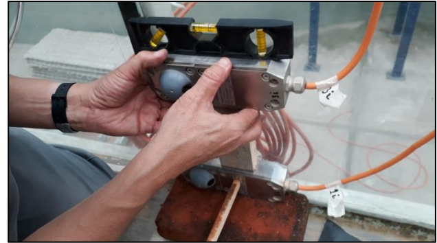
Ilustración 63: Instalación del transductor con nivel y cimbra para tener precisión en la lectura de flujo.
