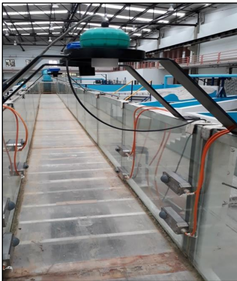
Ilustración 72: Vista transversal de sensores de nivel apoyados sobre la parte superior del canal con sus propios marcos.
