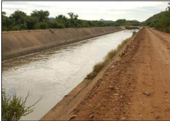
Ilustración 26: Canal trapezoidal “Humaya” km 5 + 000
