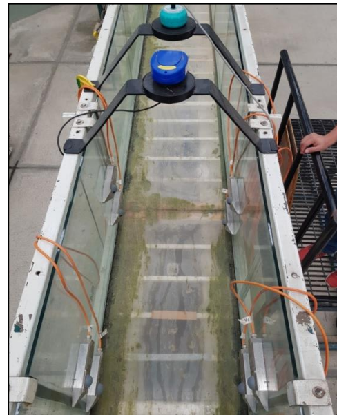
Ilustración 70: Sensores de nivel instalados en el canal rectangular del laboratorio de hidráulica Enzo Levi, IMTA.
