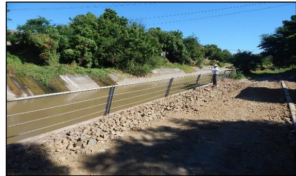
Ilustración 32: Canal principal Rosales. Sección trapezoidal.
