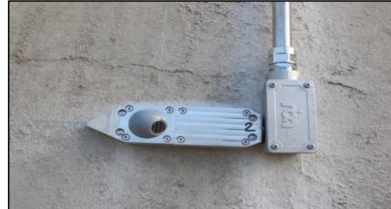
Ilustración 80: Transductor de velocidad de 1 Mhz. En la esfera se encuentra el sensor ultrasónico que con el envío de señales calcula la velocidad dentro del sistema del modulador y posteriormente calcula el gasto.
