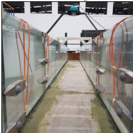
Ilustración 22: Vista transversal, sensores de velocidad y sensor de nivel montados sobre el canal.
