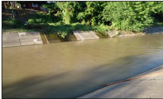
Ilustración 30: Canal principal de forma trapezoidal “Rosales”.
