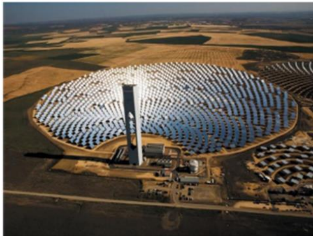
Figura 12 Torre de energía solar PS-10 de 10MW en Sevilla, España.
