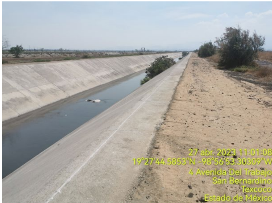
Figura 3-110. Dren Chimalhuacán. Aspecto al momento de la vista.
