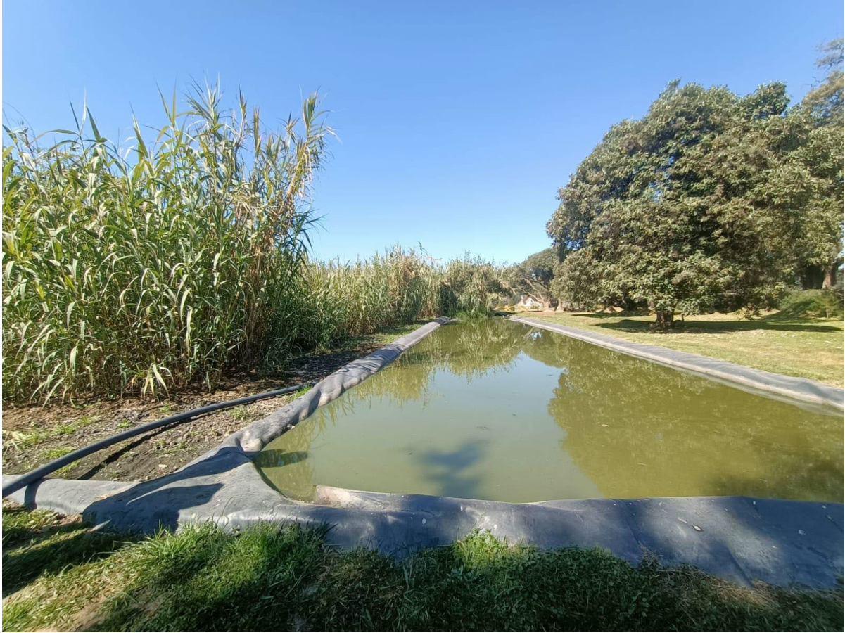
Figura 3-150. Laguna de sedimentación y humedal de flujo subsuperficial.
