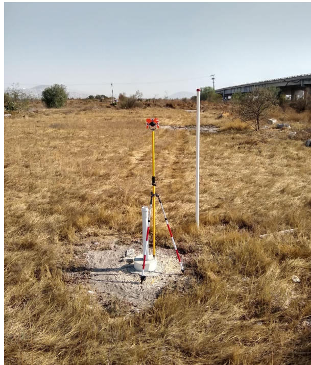
Figura 3-79. Nivelación del piezómetro 17
