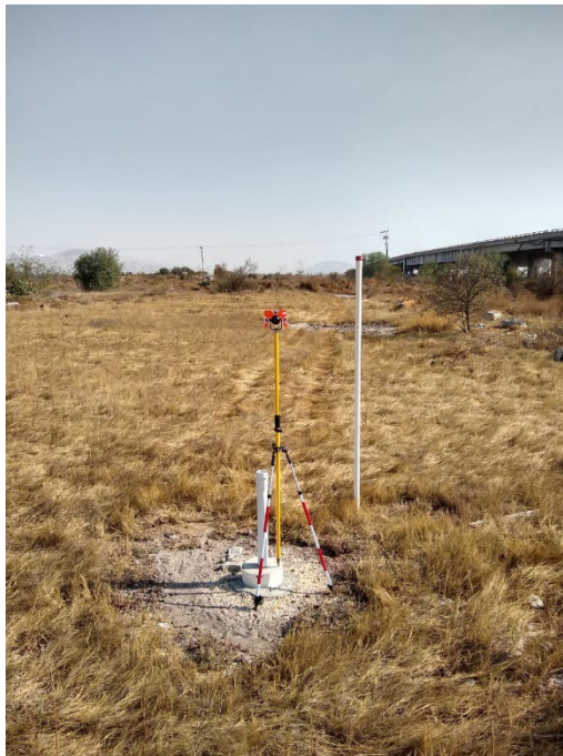
Nivelación del piezómetro
