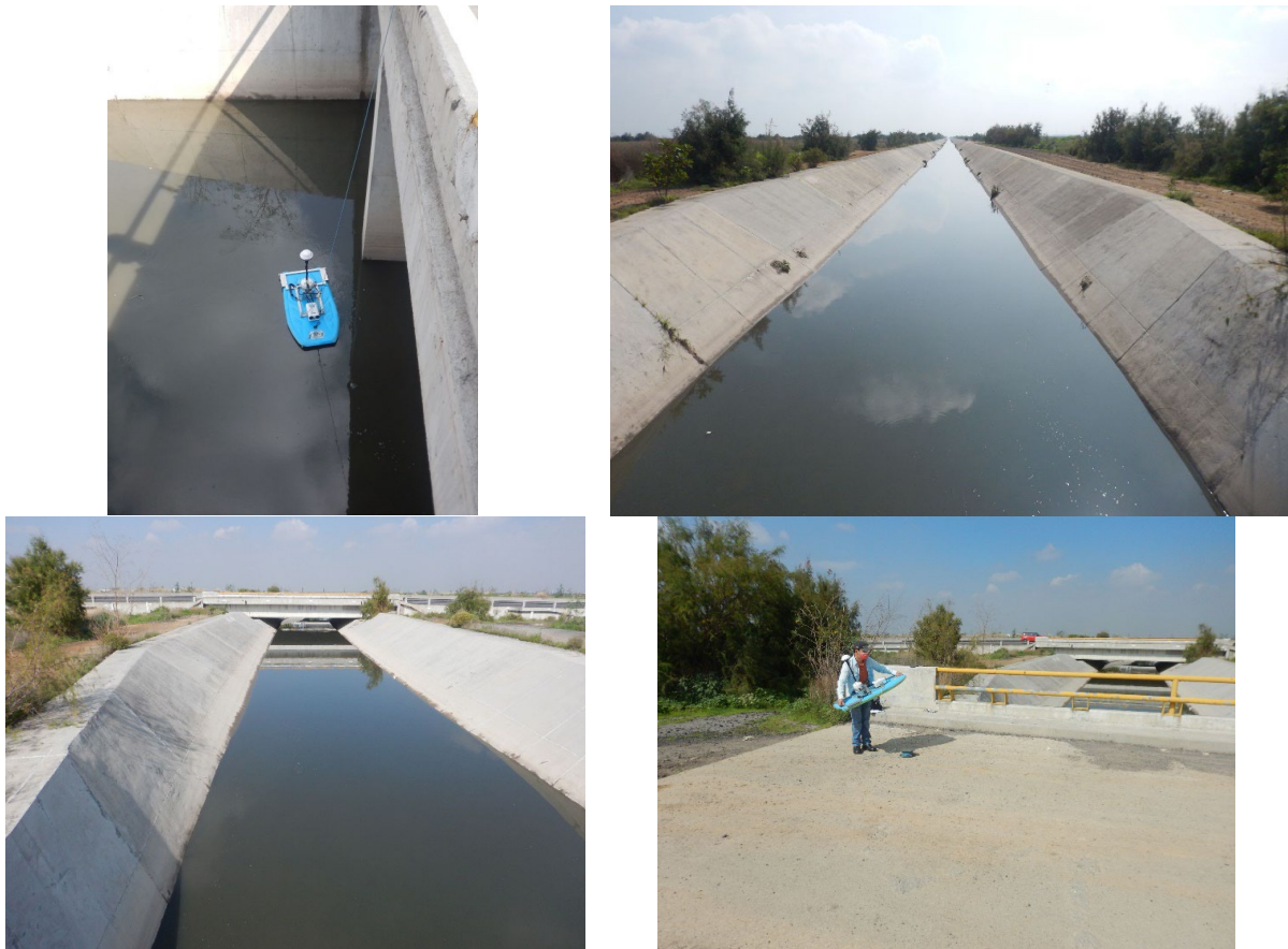
Figura 3-39. Sitio Dren Chimalhuacán 1b.
