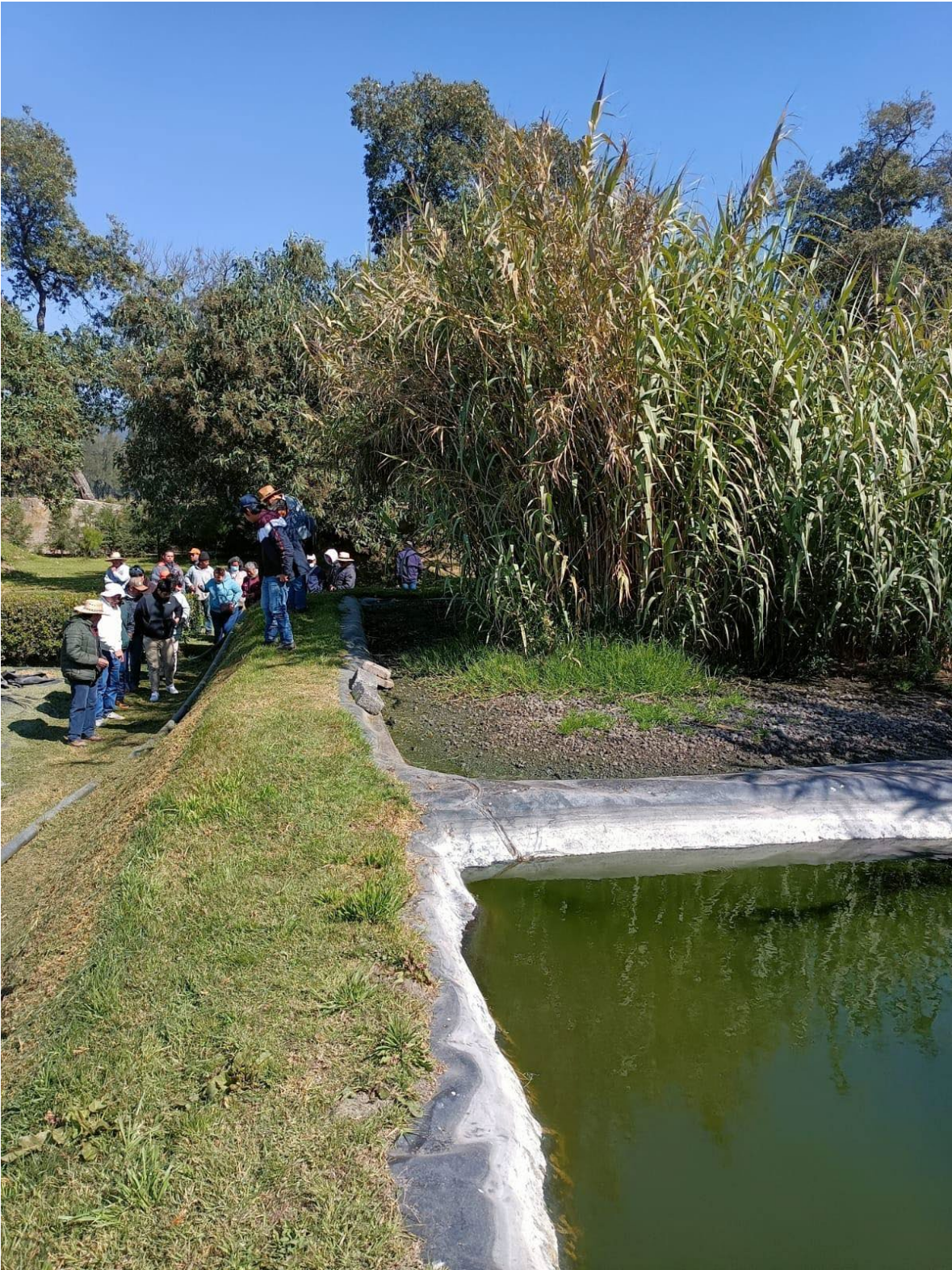
Figura 3-151. Vista del humedal subsuperficial y la laguna y laguna para el control de microorganismos.
