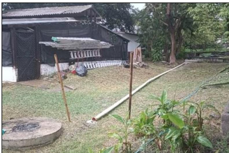
Ilustración 32. Descarga de la tubería de 4 pulgadas al LID
