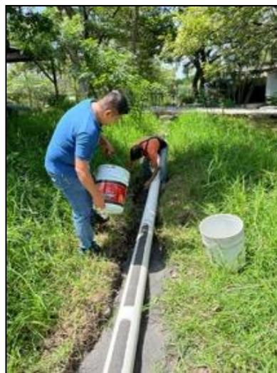
Ilustración 12. Colocación de tubería de 6 pulgadas
