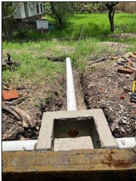
Ilustración 11. Tubería de 6 pulgadas de PVC con dirección hacia el LID
