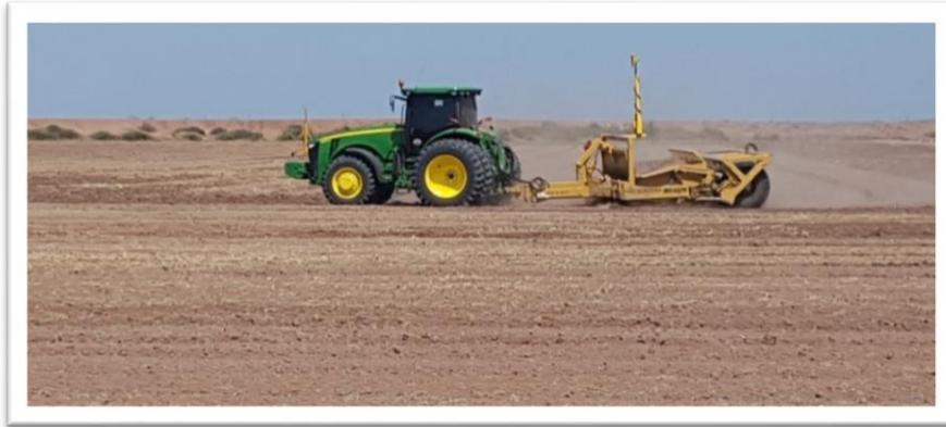
**Figura 2.65** Equipo nivelando el terreno.
