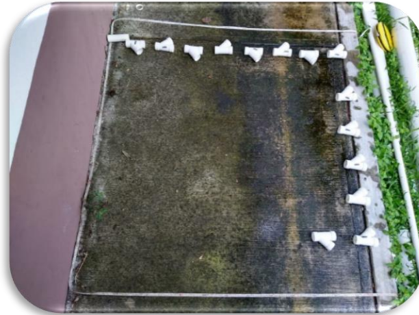
Figura 4.5 Pared frontal del edificio de Riego y Drenaje
