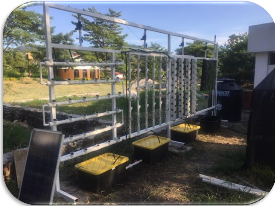
Figura 4.20 Instalación de la tubería de PVC
