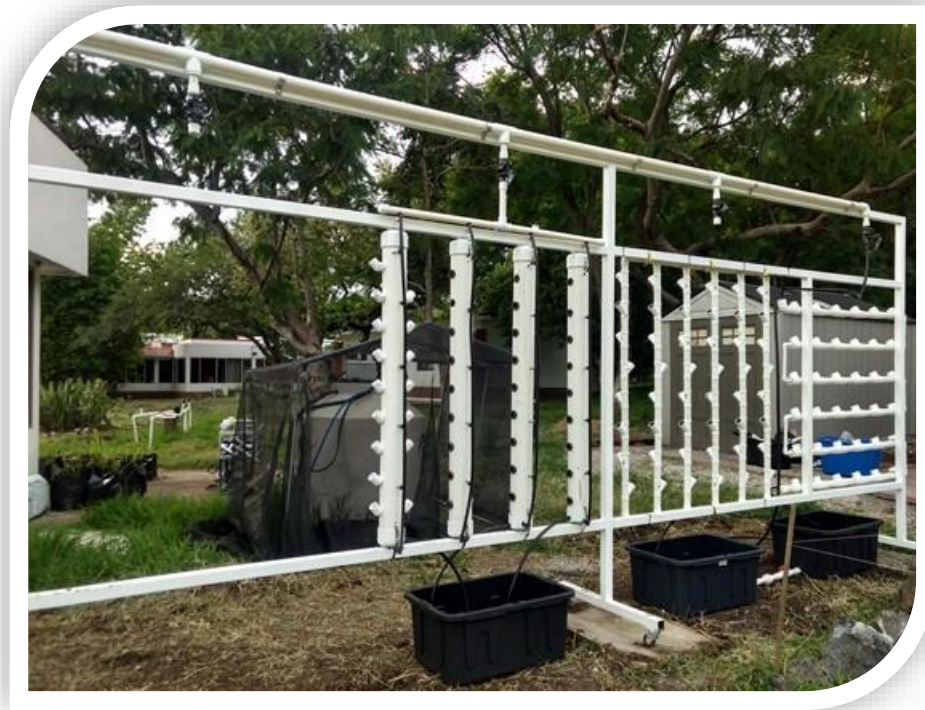
Figura 4.29 Colocación del sistema de riego a cada módulo
