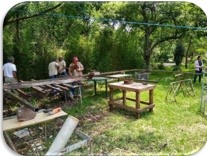
Figura 4.1 Construcción de la estructura metálica
