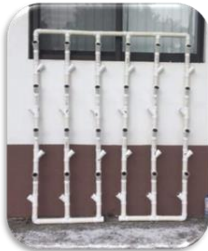
Figura 4.22 Instalación de la tubería de PVC, sistema de Y's
