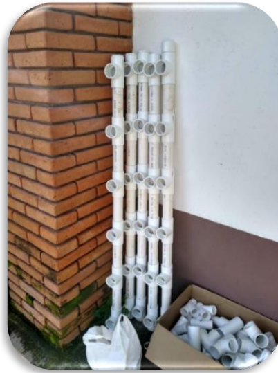
Figura 4.3 Construcción del sistema para hidroponía zigzag
