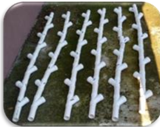
Figura 4.22 Instalación de la tubería de PVC, sistema de Y's
