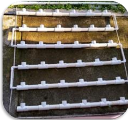
Figura 4.21 Instalación de la tubería de PVC, sistema de T's
