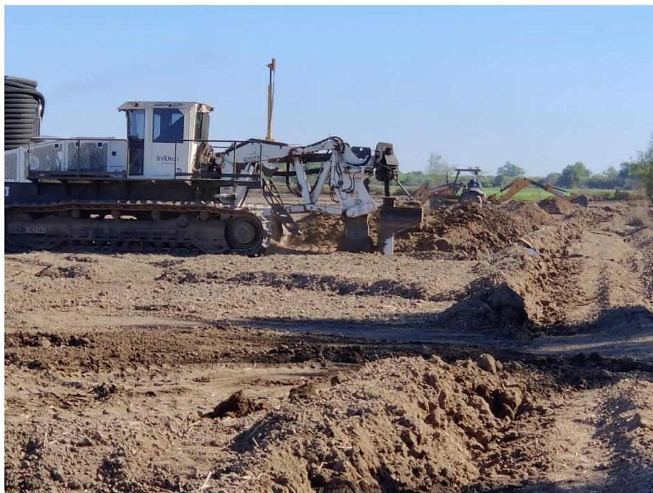
Figura 104. Abriendo ventanas para iniciar la instalación de la línea, previo coplee al colector
