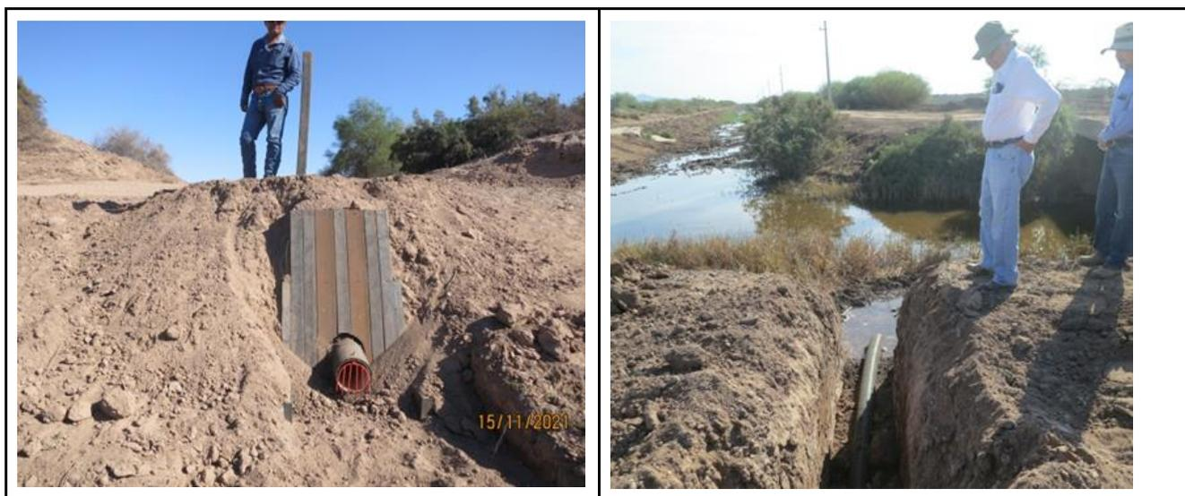
Figura 71. Descarga a los drenes a cielo abierto.
