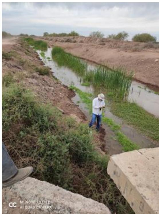
Figura 51. Dren a cielo abierto con maleza y azolve, todavía tiene profundidad suficiente
