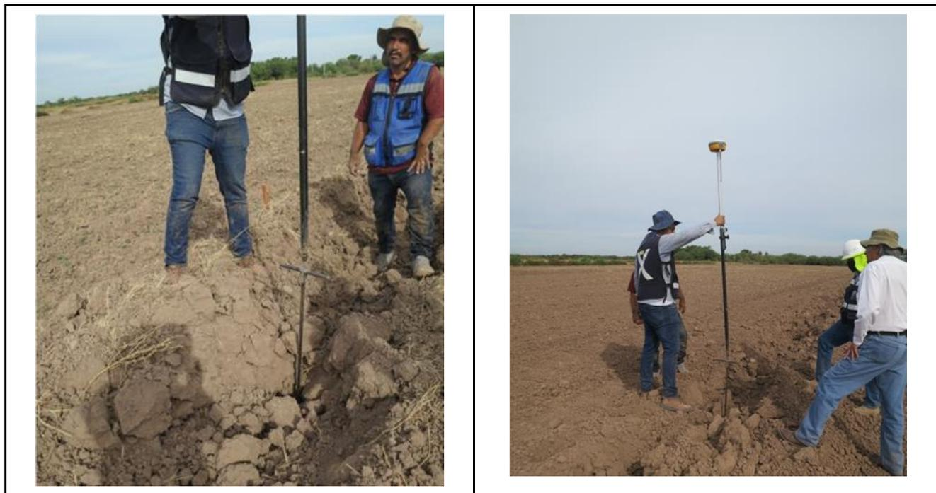
Figura 70. Sondeo sobre las líneas de drenaje instalado
