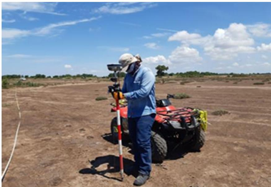
Figura 55. Georreferenciación de la línea con el colector
