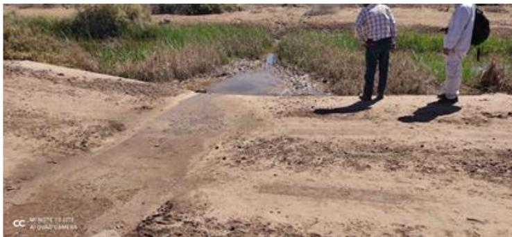
Figura 48. Dren colmatado por arrastre de sedimentos
