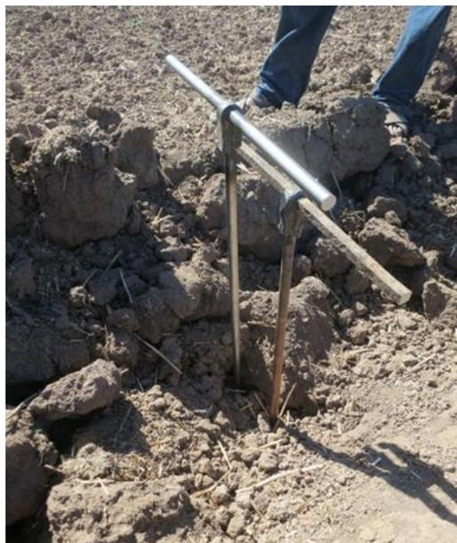
Figura 69. Sondas para verificar la tubería instalada
