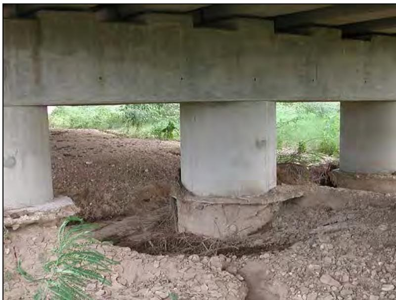
Fotografía 2 Socavación al pie de las pilas del puente del río Lagartero
