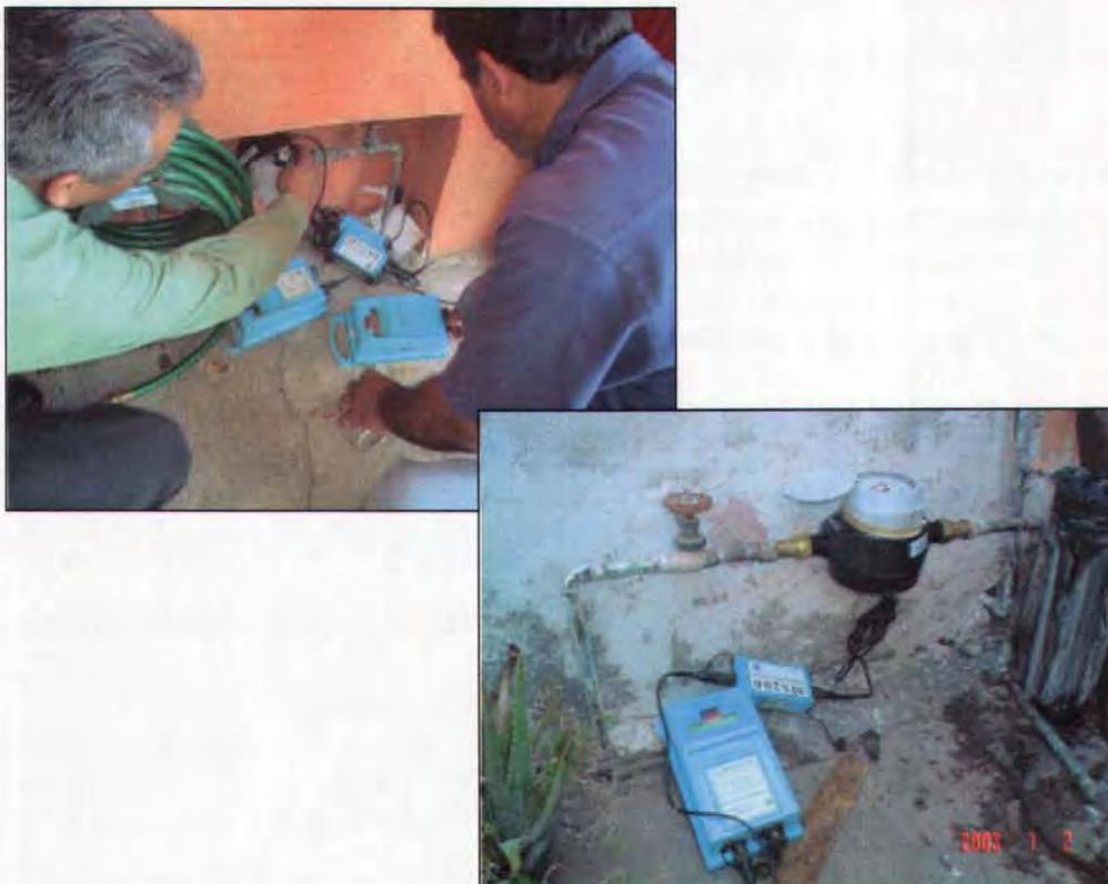
Ilustración 14. Instalación de Data-Logger y sensor magnético de pulsos.
