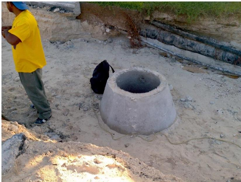
Ilustración 5.4.4.6. Pozos de visita instalados en la zona.
