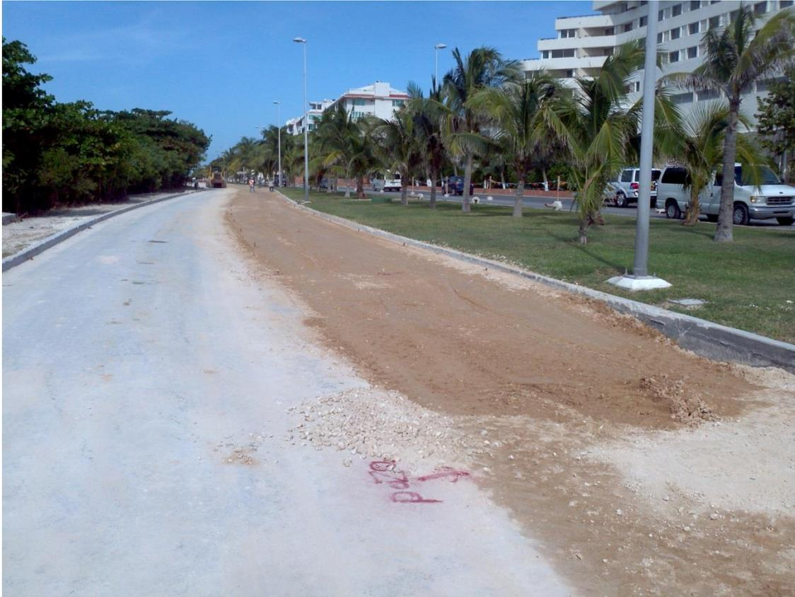
Ilustración 5.4.4.13. Falta el pavimento de la calle.
