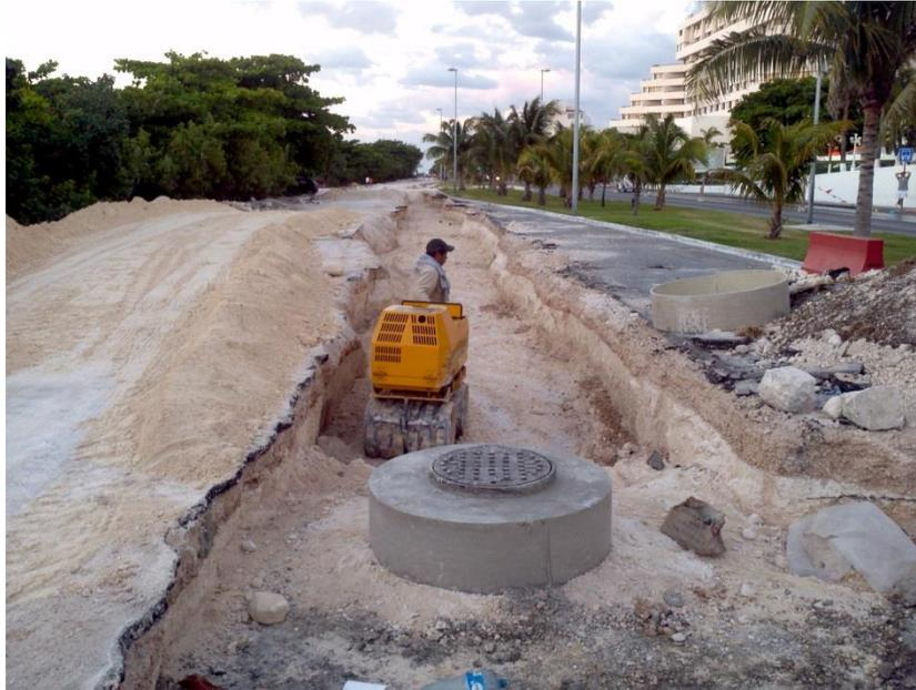
Ilustración 5.4.4.9. Colectores totalmente instalados.
