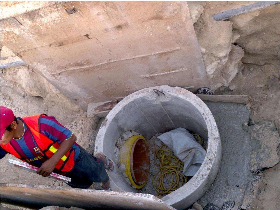
Ilustración 5.4.4.8. Detalle en la interconexión de los pozos de visita.
