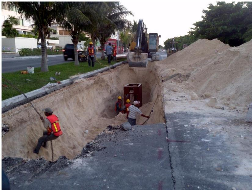
Ilustración 5.4.4.4. Excavación de las zanjas para la instalación de los colectores.
