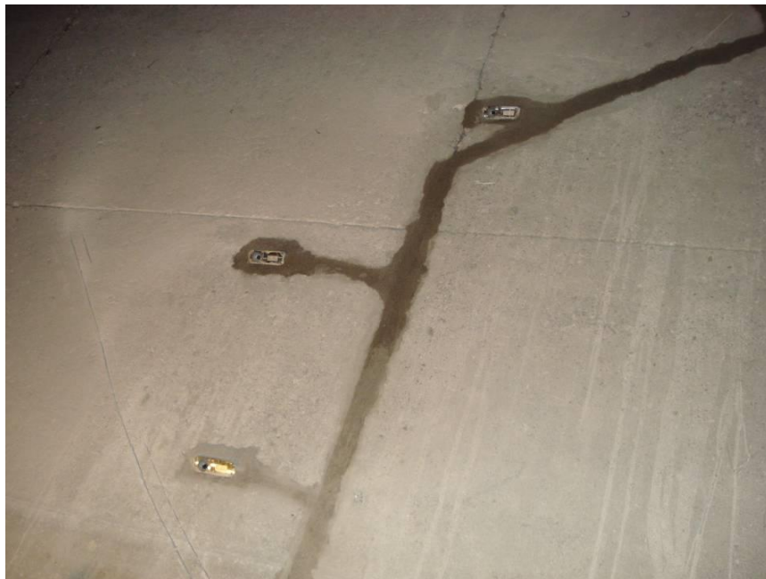
Fig. 3. Sensores de velocidad dentro del canal.
