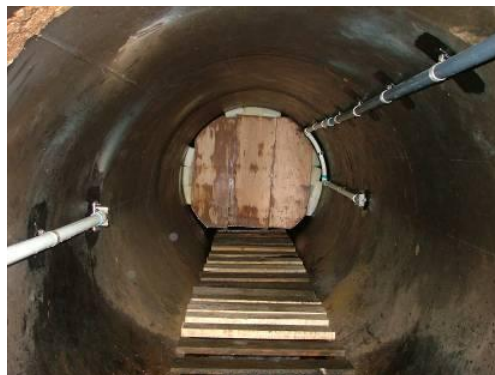
Foto 3 Instalación de ATT de un par interno en la presa Ignacio Allende (CONAGUA/IMTA, 2005)
