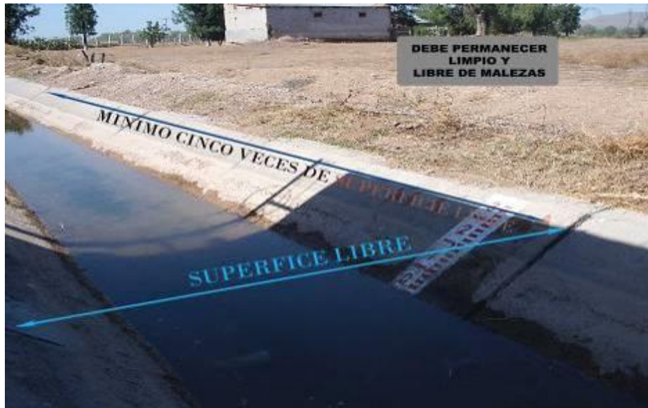
Conservación de la obra civil
