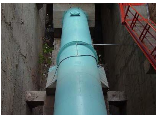
Foto 4 ATT de un par externo Presa Francisco I. Madero (CONAGUA, 2003)
