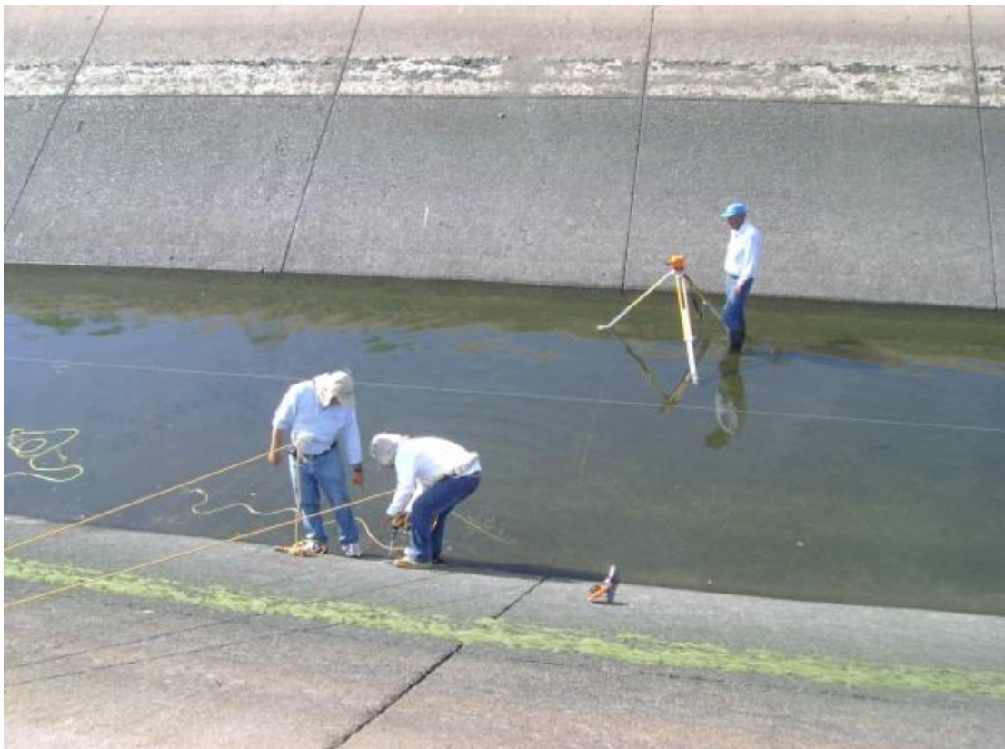
Medición de la sección de un canal
