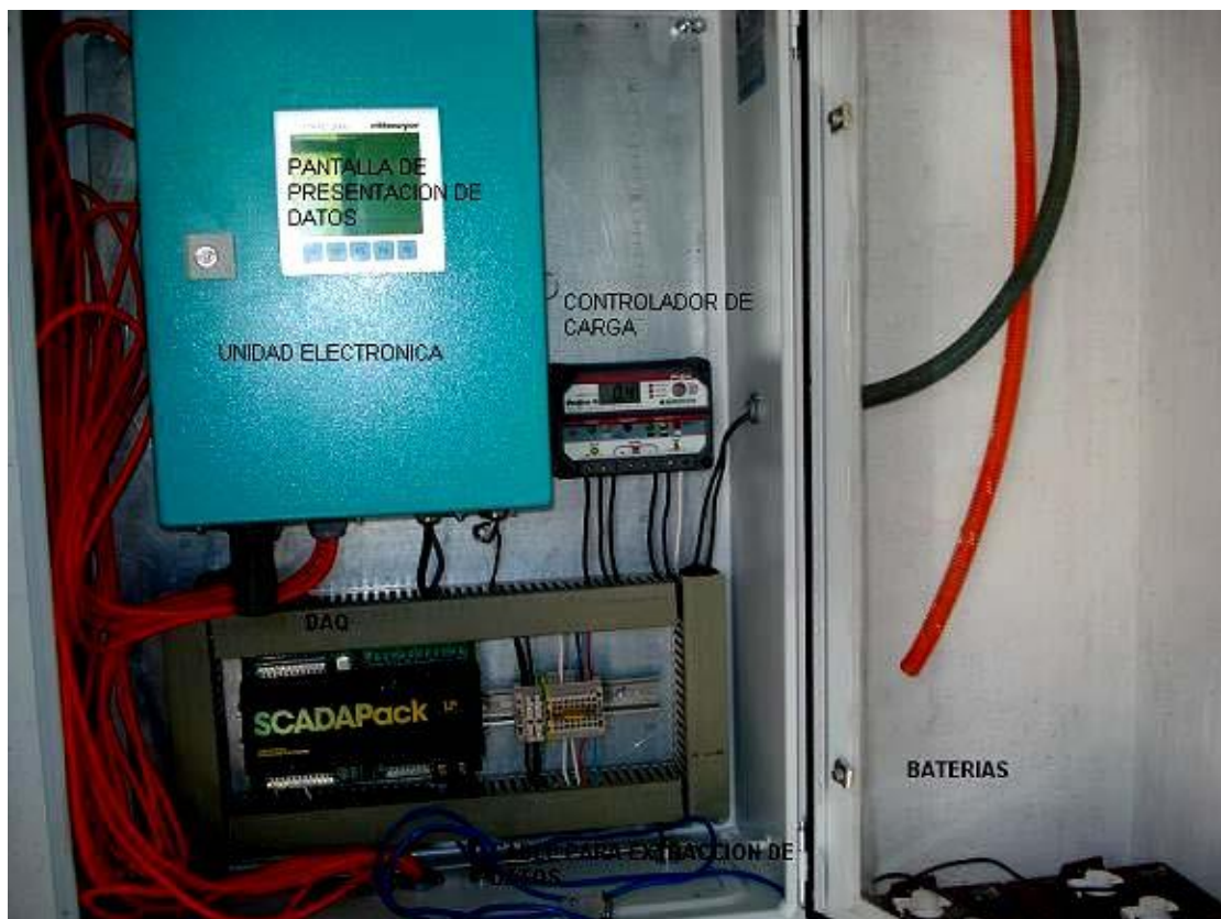
Fig. 1. Componentes alojados en un gabinete Nema 4
