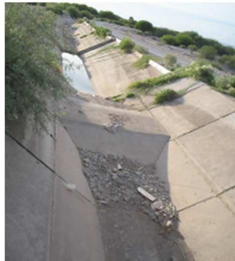
Verifique la nivelación de la cresta de la estructura.
