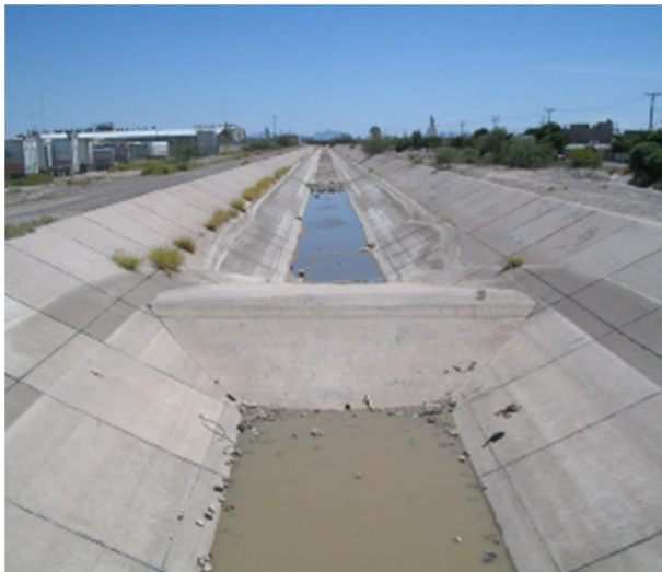
Huella del flujo sobre los taludes del AGL
