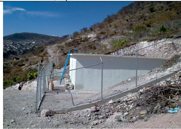
Otro tanque nuevo
