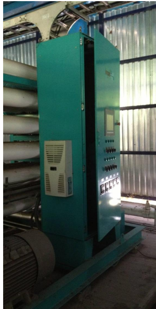
Ilustración 2.6. Tablero de control de un banco de ósmosis inversa
