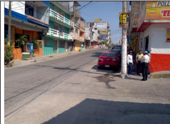
En la zona centro no se encontraron las cajas de válvulas
