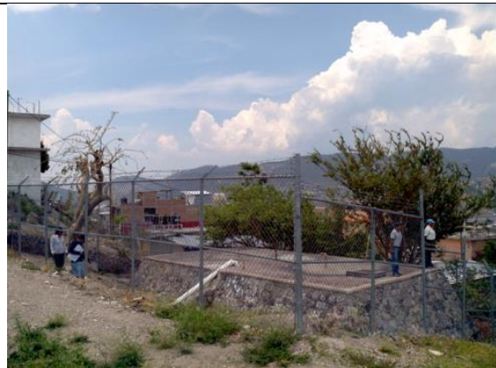
Cambio de tubería de llega al tanque de 2" a 4"
