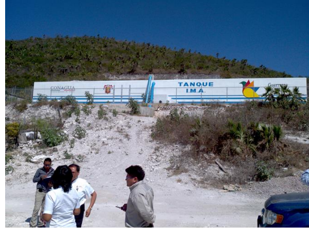
Sustitución de tanque de 70 m 3 por un Tanque maestro nuevo, cap.1500 m 3
