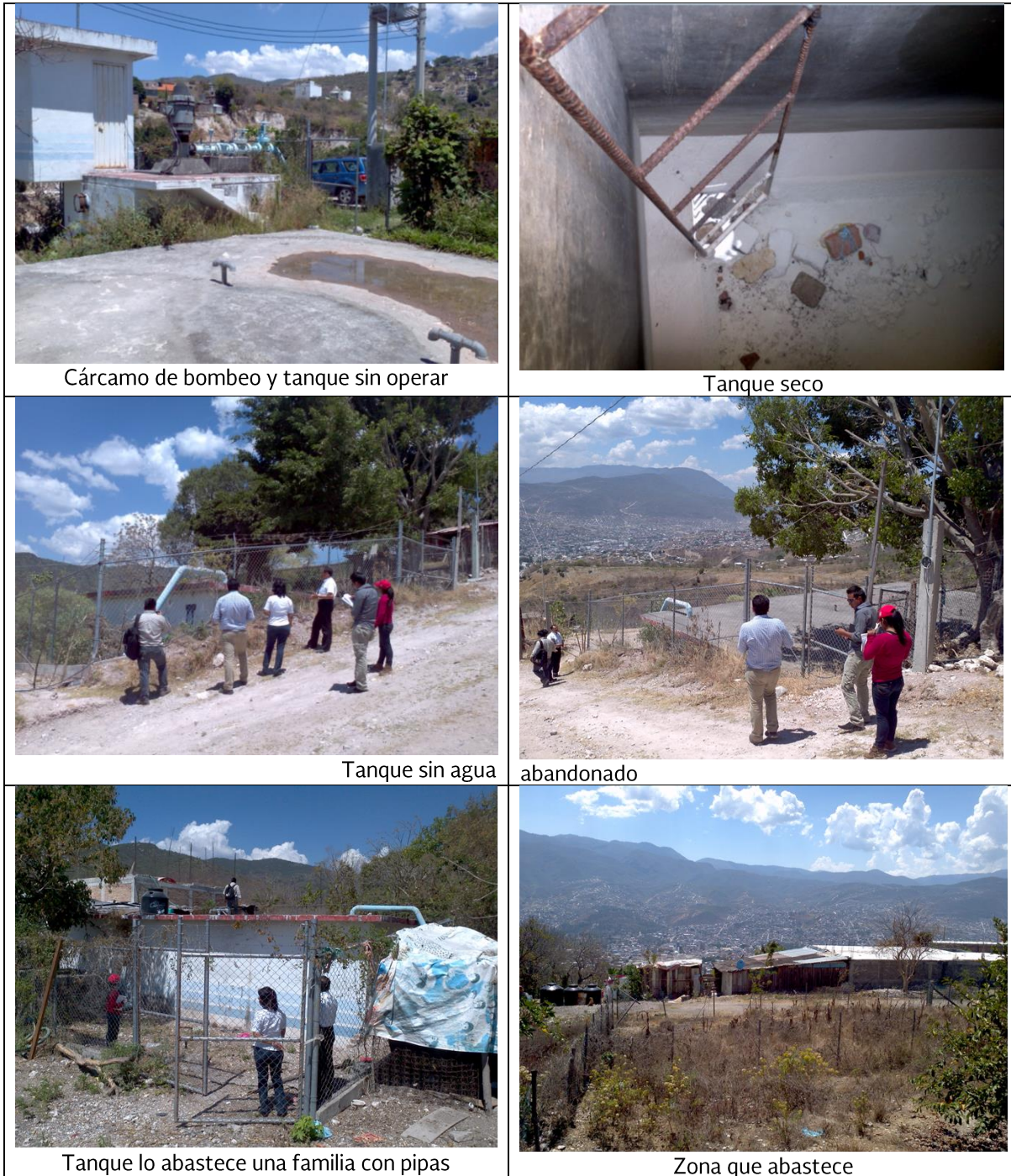
Ilustración 1.66. Falta de agua en las partes altas de la ciudad
