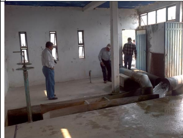
Vertedor Parshall para aforar dos llegas no es recomendable en este caso están juntas.
