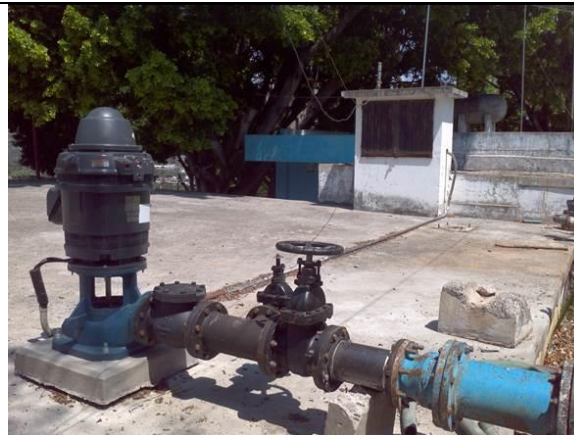
Segundo equipo de bombeo sustituido en el tanque El Tomatal
