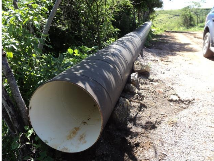
Ilustración 1.50. Tubería por instalar de 24"
