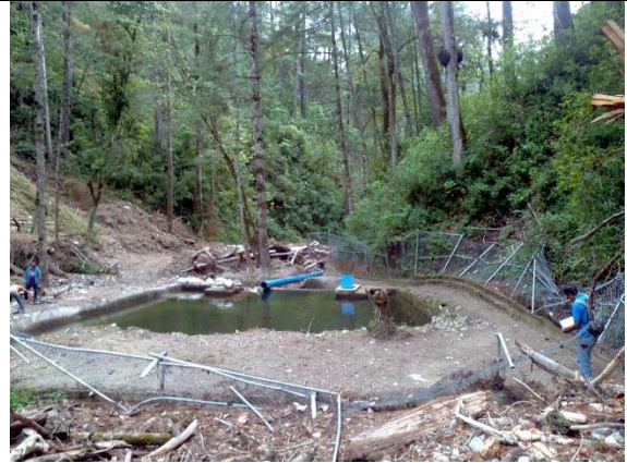
Trabajos de rehabilitación por la tormenta Manuel, se va instalar una nueva línea.
