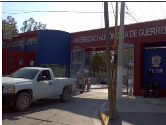
Instalaciones de Universidad de Chilpo.
