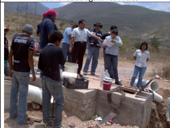
Nuevas líneas de conducción
