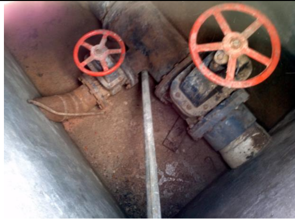
Cambio de válvulas y ampliación del diámetro de la línea
