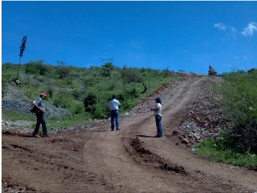
Ilustración 1.52. Trabajos terminados de la instalación
