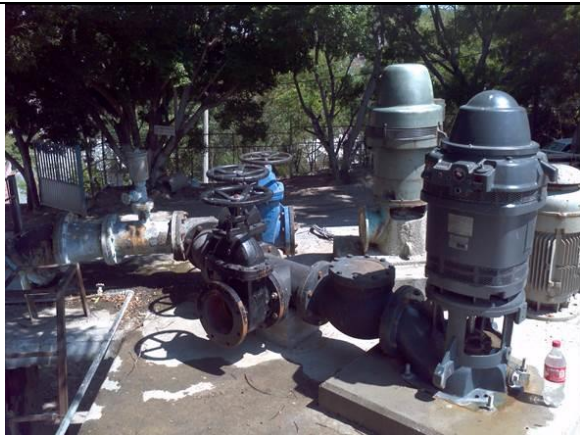
Sustitución del equipo de bombeo en el tanque El Tomatal
