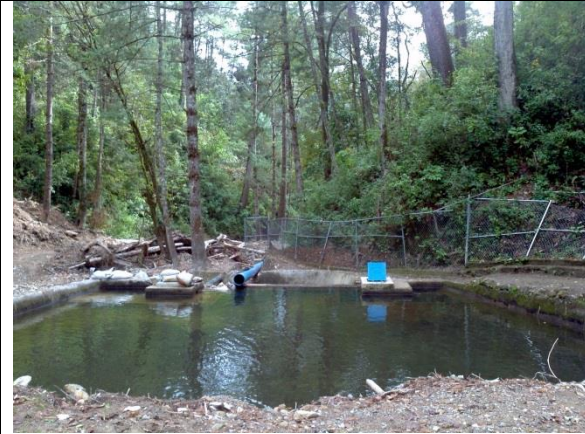
Captación agua Fría
