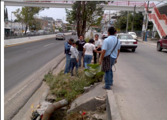
Tubería recibe aguas residuales
