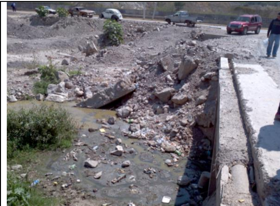
Derivación de PVC encofrada
