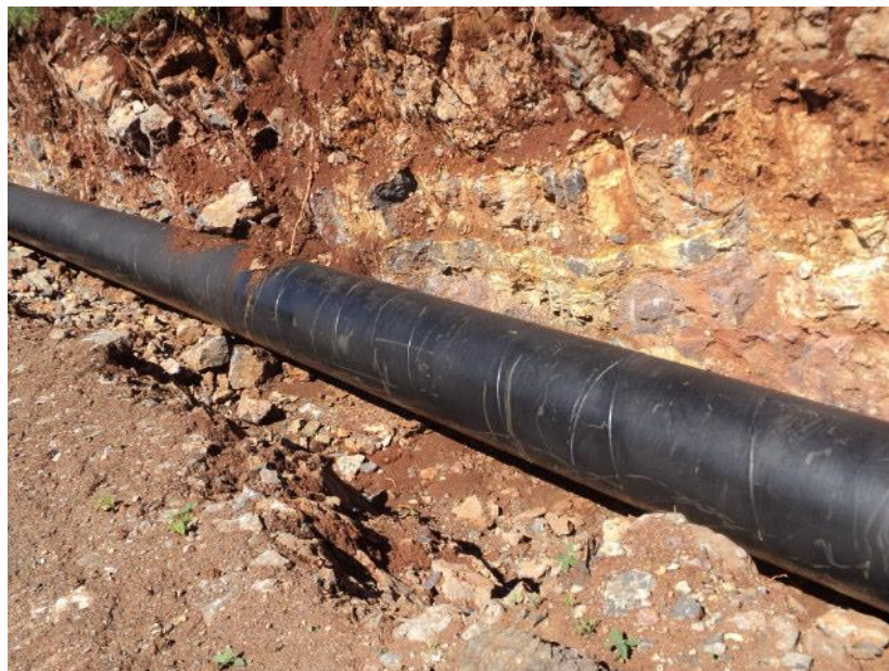
Ilustración 1.51. Tubería colocada en zanja
