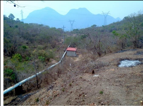
Línea de conducción de la Planta de bombeo #1 para abastecer el cárcamo de bombeo #2
