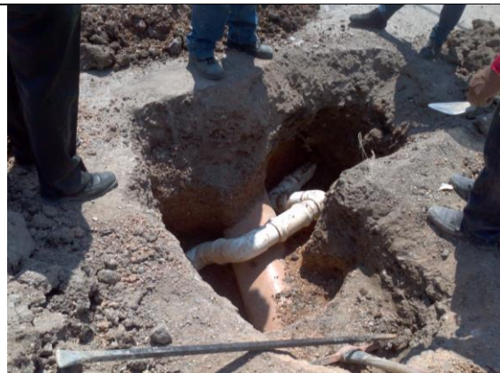
Modificaciones en caja de válvulas
