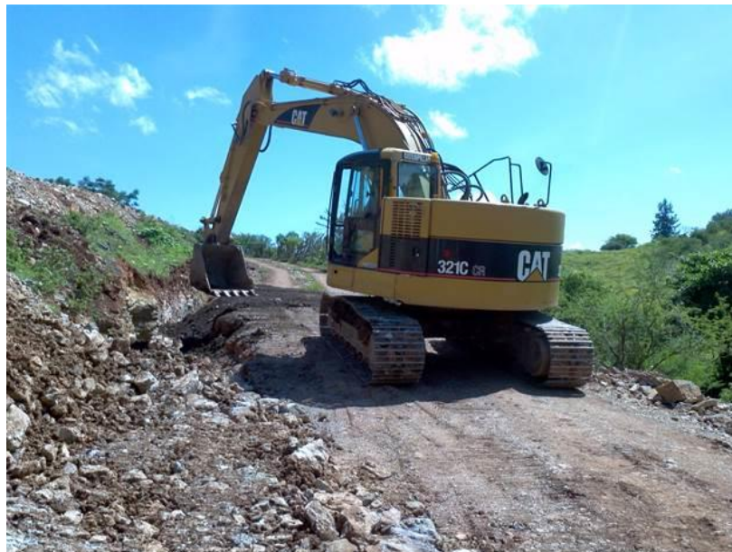
Ilustración 1.53. Relleno de la zanja
