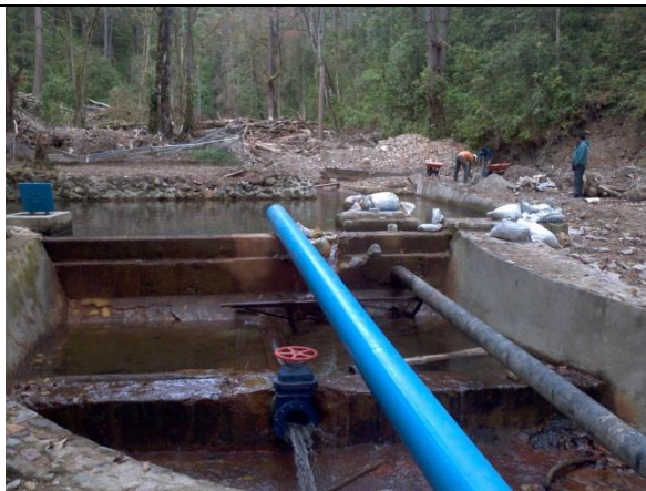
Sitio donde se instalará la nueva línea
