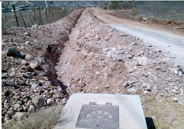
Ilustración 1.68. Construcción de nuevos tanques y zanja para instalar nueva línea
