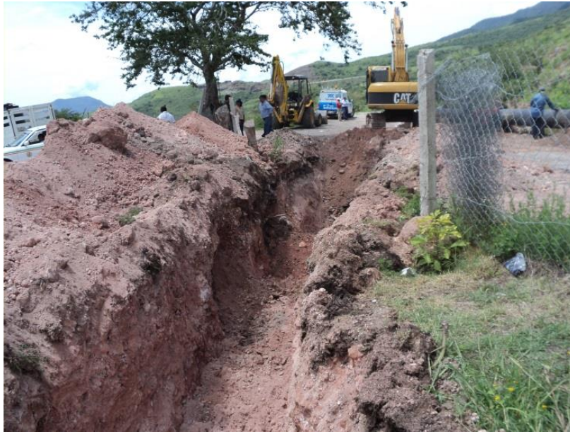
Ilustración 1.55. Trabajos de excavación
