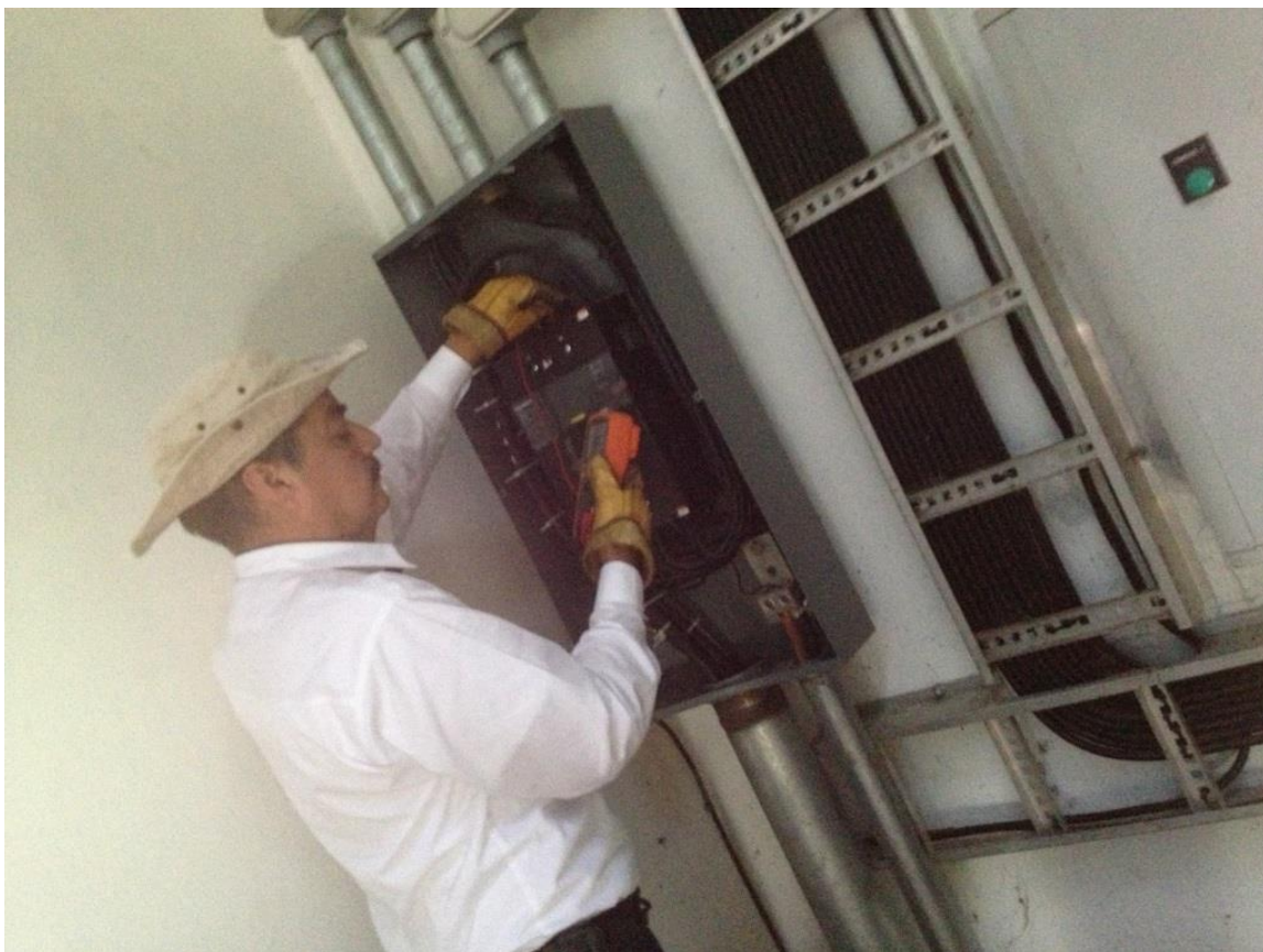
Ilustración 2.4. Medición de corriente eléctrica en la acometida
