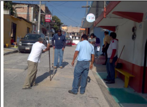
Destapando caja de válvulas
