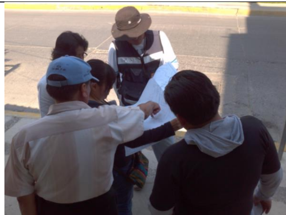
En Av. Lázaro Cárdenas revisando línea de conducción
