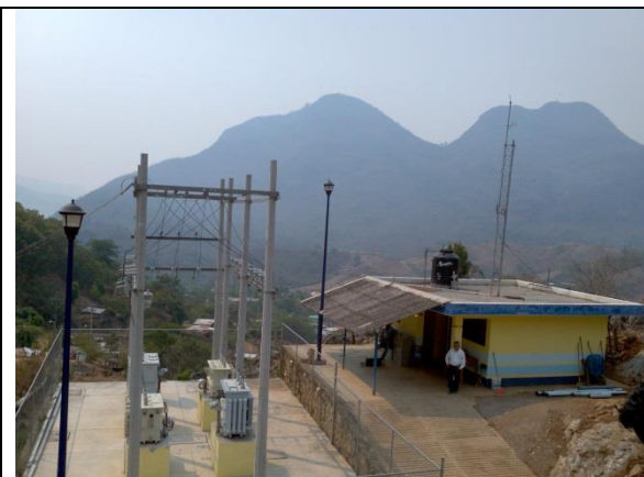
Caseta de control de la Planta de bombeo #1
