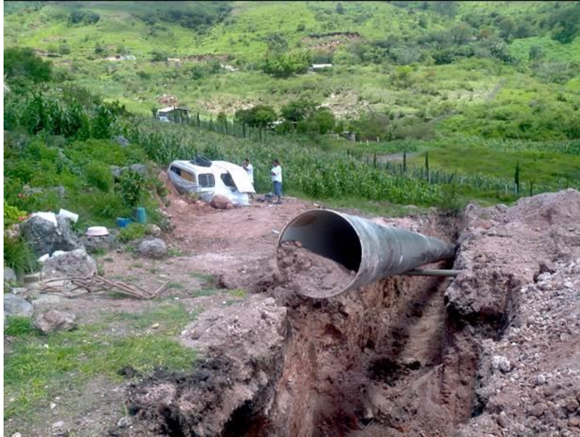
Ilustración 1.57. Instalación de la línea nueva antes de los terrenos que no permiten el paso el cruce por sus propiedades
