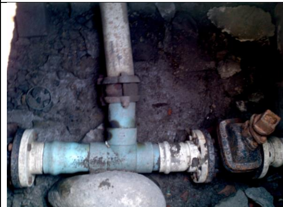
Sustitución de cruceros
