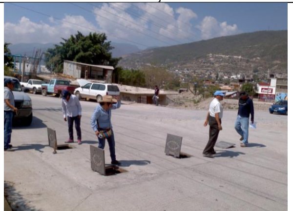
Rehabilitación de cajas de válvulas nuevas derivaciones.
