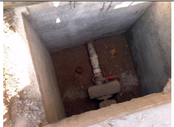
Cortaron la línea de 2 1/2" y colocaron una válvula de cierre rápido.
