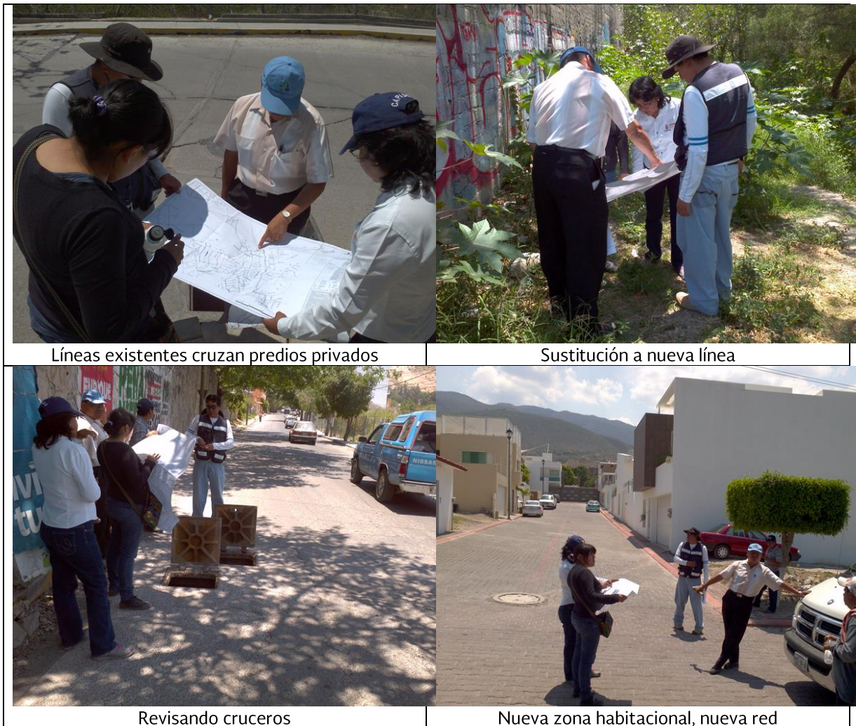
Ilustración 1.65. Cotejando lo del plano con lo existente en campo
