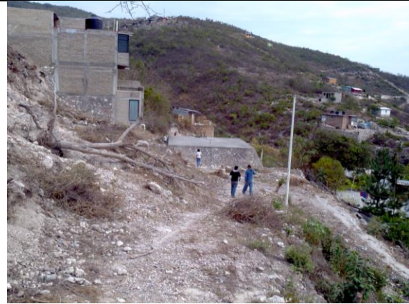
Otro tanque nuevo
