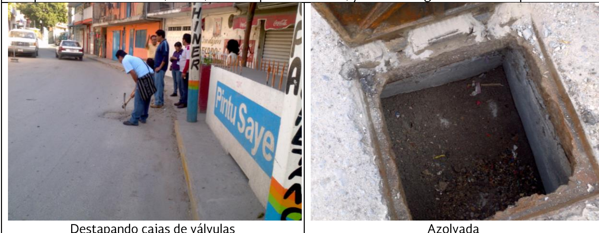
Ilustración 1.69. Tanque maestro San Mateo e inspección de cajas de válvulas
