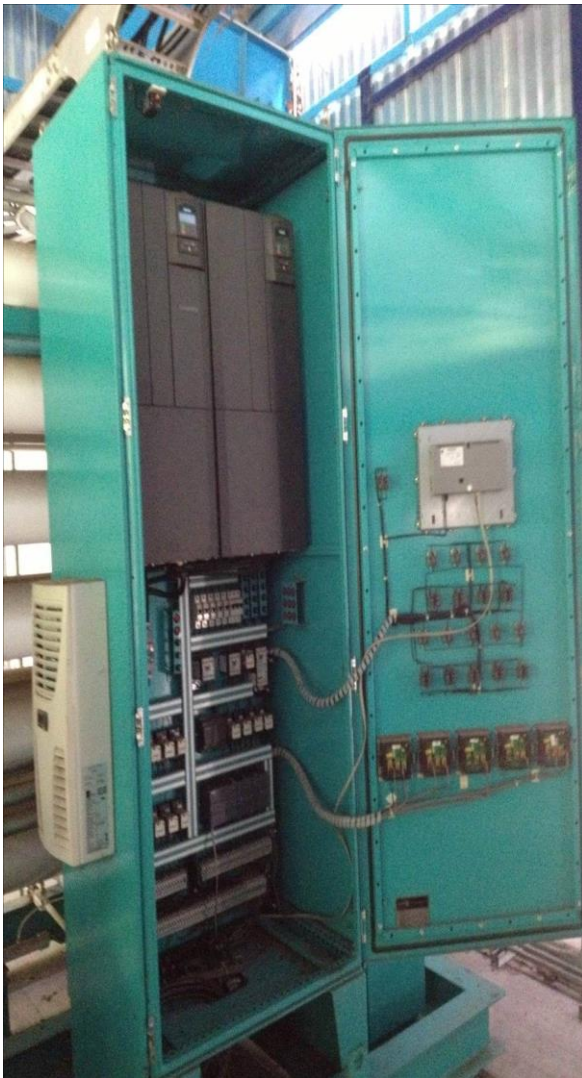
Ilustración 2.6. Tablero de control de un banco de ósmosis inversa
