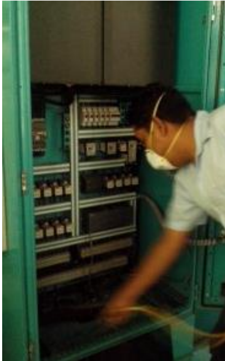
Ilustración 2.7. Sopleteo con aire seco para la limpieza de los tableros
