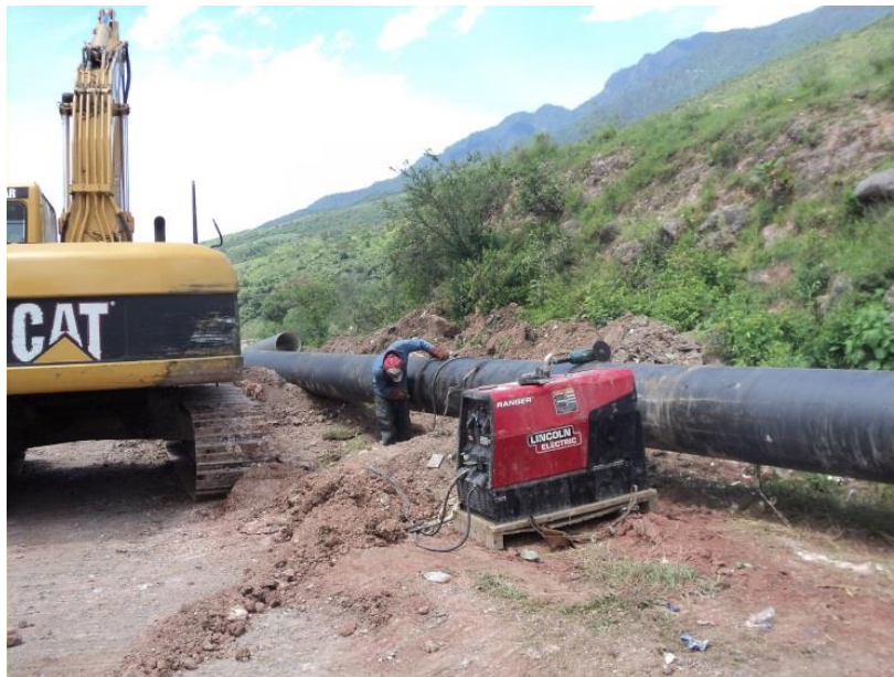
Ilustración 1.56. Trabajos en el segundo tramo visitado
