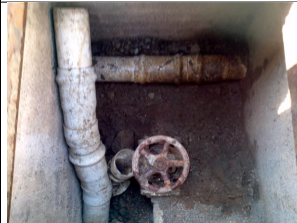
Sustitución de líneas según cajas de válvulas
