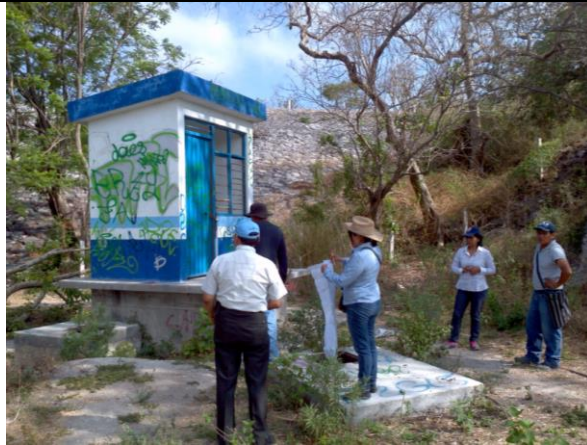
Aguas debajo de la cortina de la presa se cambió el diámetro de la tubería.
