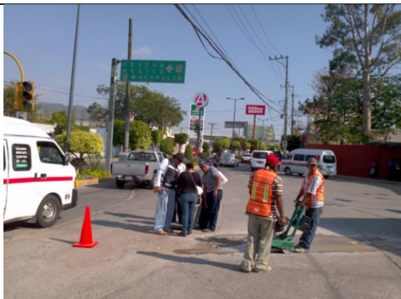
Trabajos de interconexión para abastecer a la Universidad
