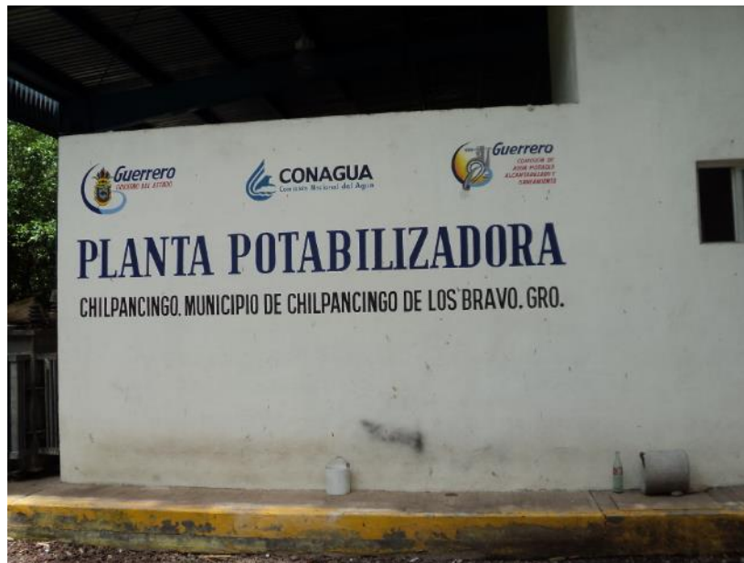
Ilustración 1.58. Planta fuera de operación debido al corte de energía eléctrica
