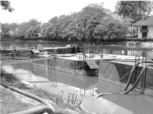
Ilustración 9. Tanques flotantes-sumergibles en la orilla del vaso.
