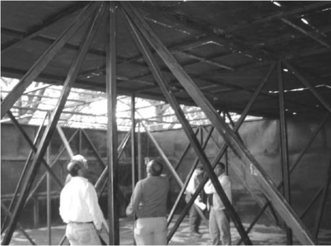
Ilustración 8. Vista interior de los tanques con refuerzos.
