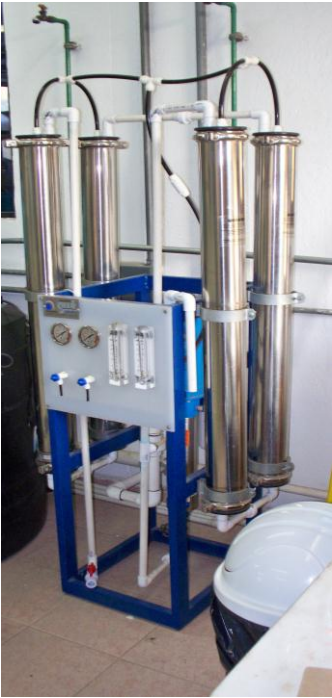
Figura 3- 2 Sistema de desalación por Nanofiltración.
