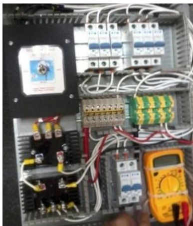
Figura 1. 11 Armado de circuito de control de los aerogeneradores
