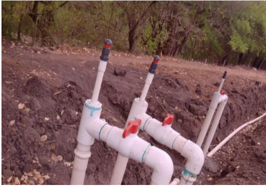
Figura 2- 9 Instalación del sistema de riego
