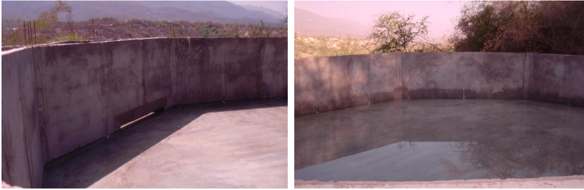
Figura 2- 6 Construcción del reservorio
