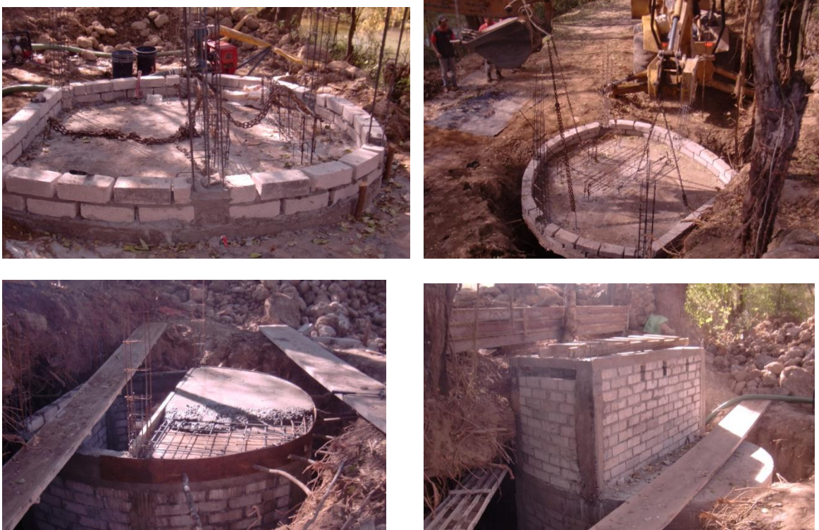
Figura 2- 7 Construcción del cárcamo
