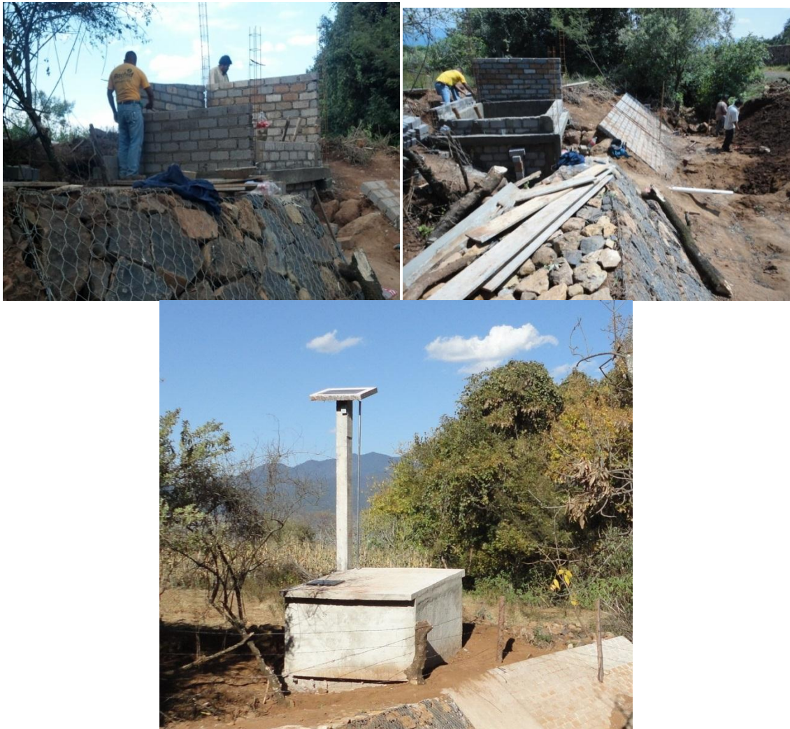
Figura 38. Construcción de la caseta de la microcuenca Malacate.
