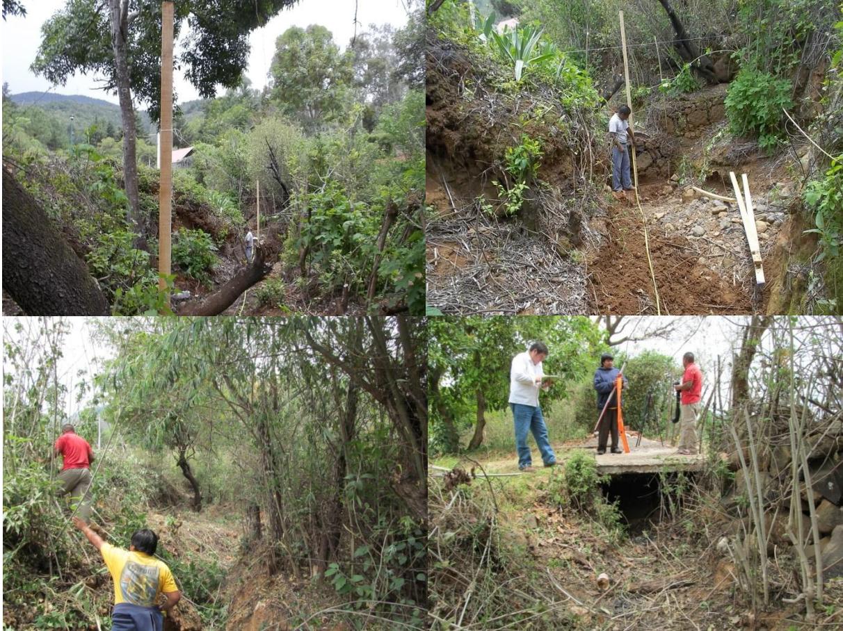
Figura 35. Limpieza del cauce y trazo del vertedor para su construcción.
