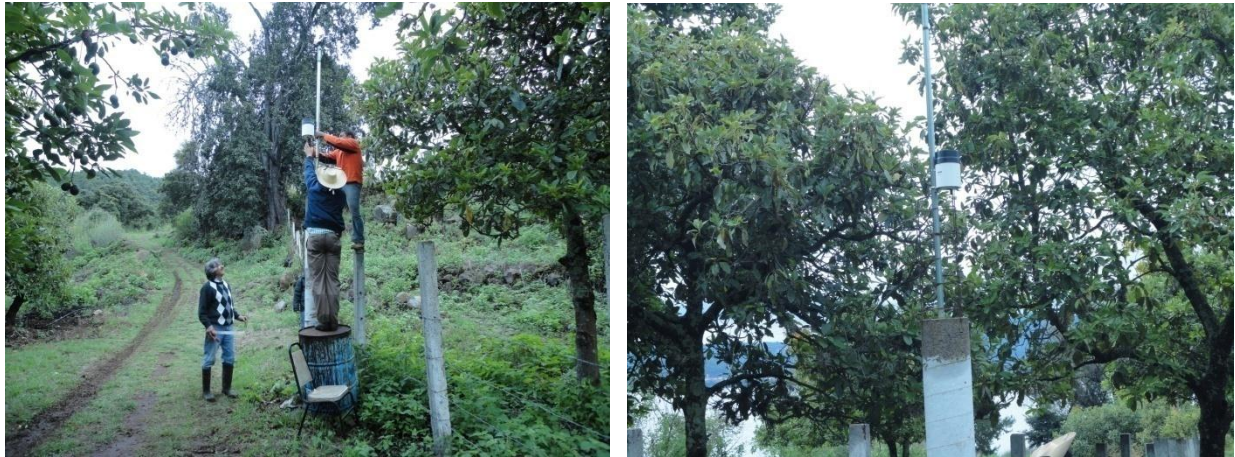
Figura 29. Instalación del pluviómetro en la microcuenca Ichupio.
