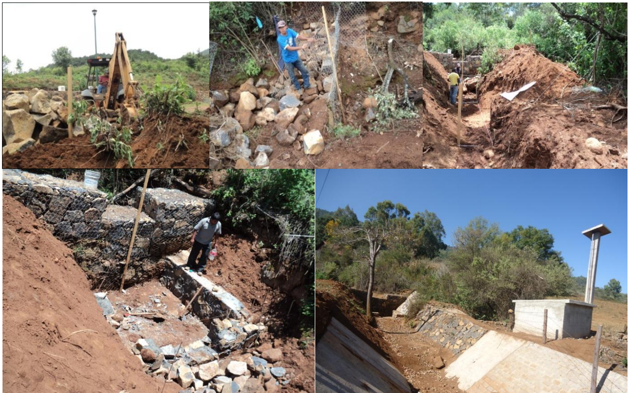
Figura 37. Serie de trabajos para la construcción del vertedor en la microcuenca Malacate.
