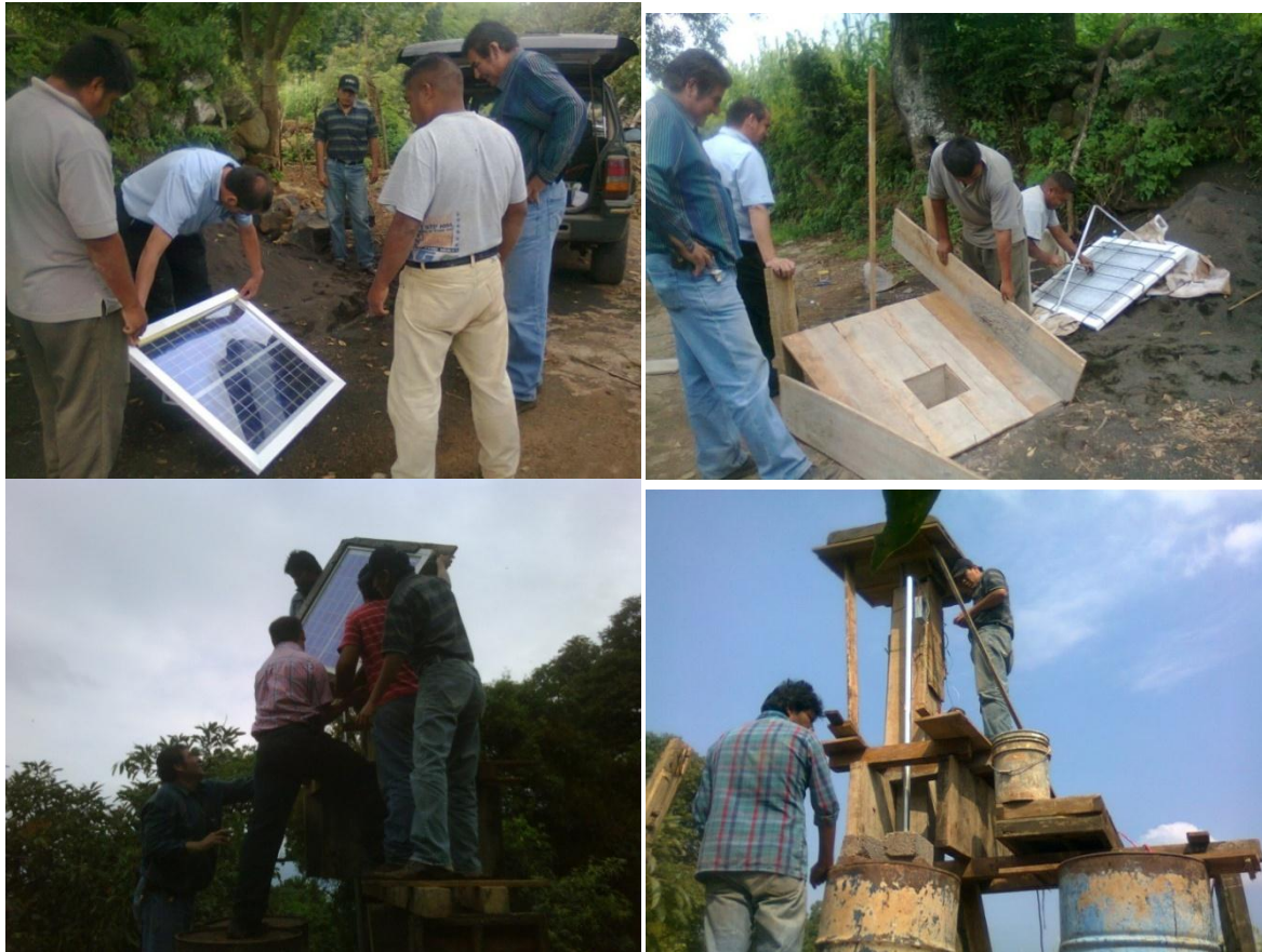
Figura 39. Construcción e instalación del panel solar.
