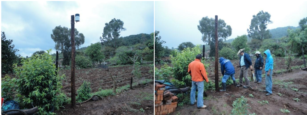
Figura 28. Instalación del pluviómetro en la microcuenca Malacate.
