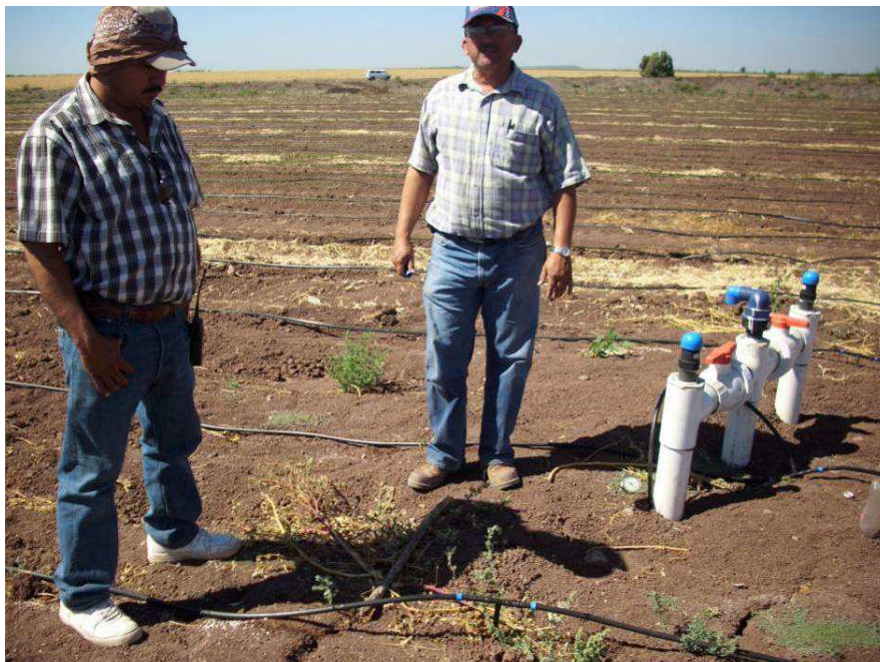
Imagen 3.42. Unidad de control autónoma en sistema de riego por goteo.
