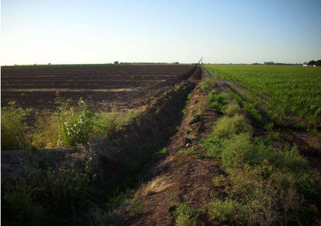
Regadera principal y auxiliar construida con bordero y canalera el 14 de marzo de 2013
