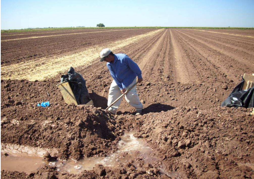
Preparación del sitio para estructuras de madera 19 de marzo de 2013
