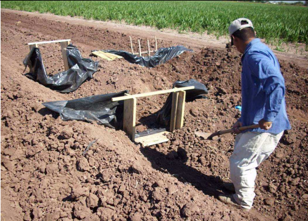
Instalación de estructura de madera individual 19 de marzo de 2013
